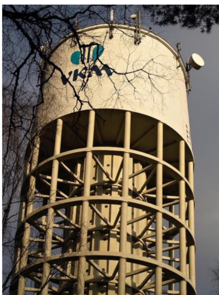
Obrázek 13- Věžový vodojem Kladno-Rozděl (Středočeské vodárny, 2023)
