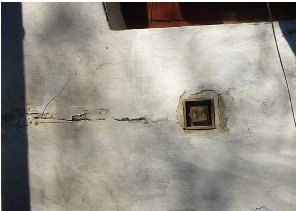
Příloha č. 26 Špatný stav elektroinstalace (Zdroj: autor, 2016)
