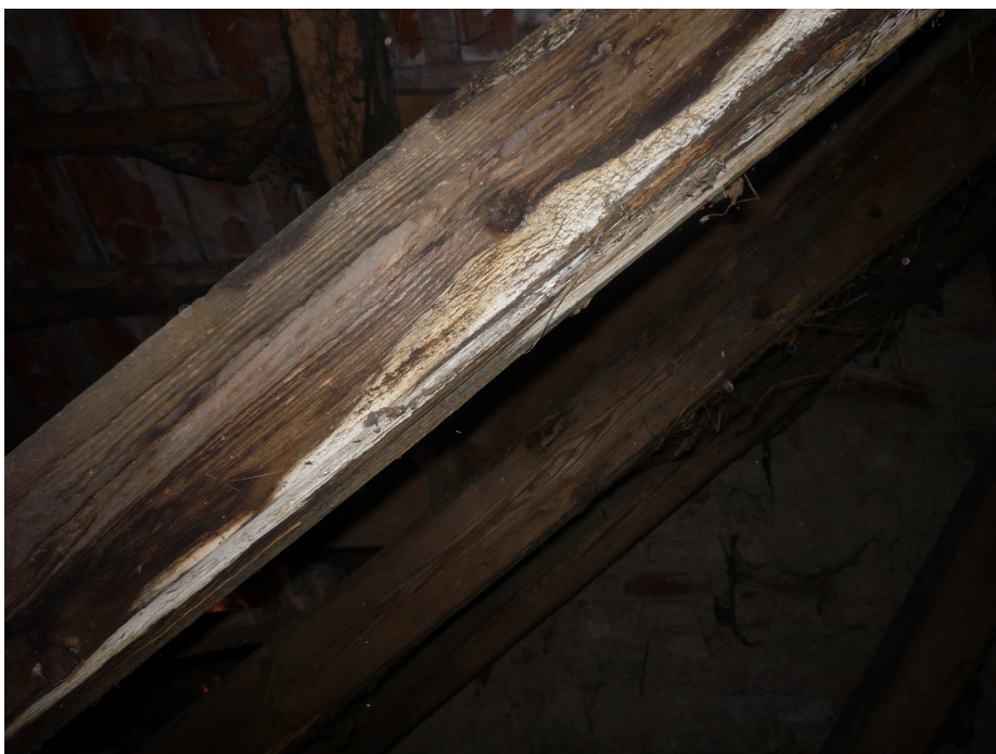
Příloha č. 12 Krokev napadená dřevomorkou domácí (Zdroj: autor, 2016)
