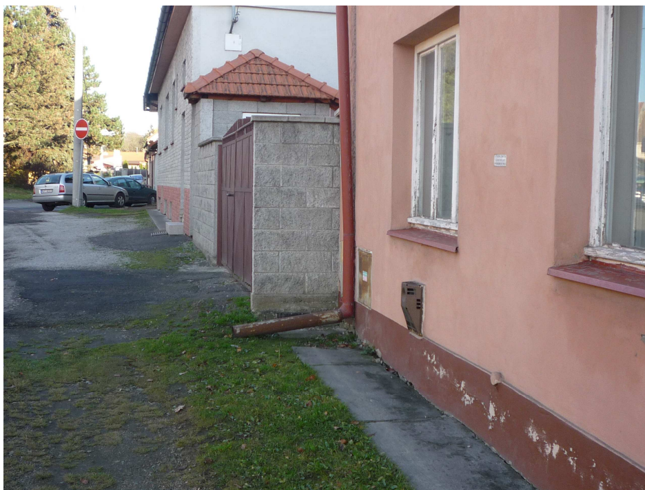
Příloha č. 18 Chybějící napojení na dešťovou kanalizaci (Zdroj: autor, 2016)
