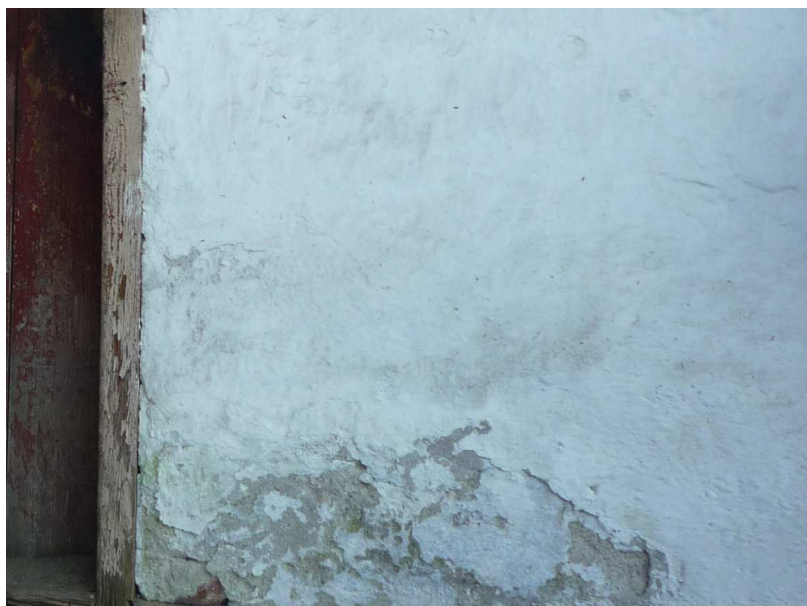
Příloha č. 30 Biogenní porucha fasády (Zdroj: autor, 2016)
