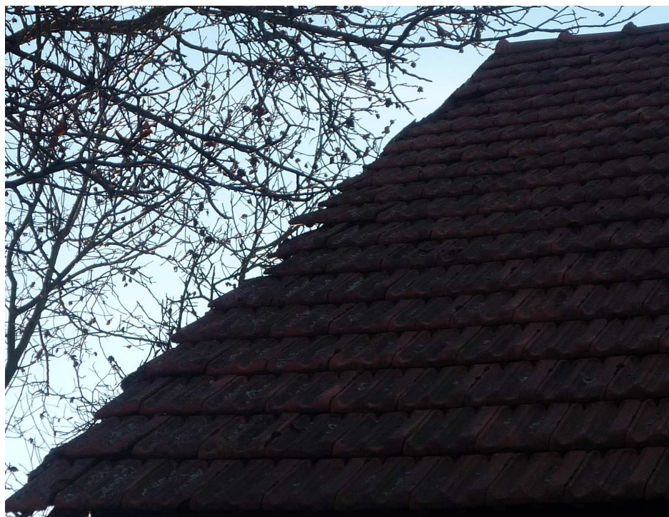
Příloha č. 14 Degradace střešní krytiny (Zdroj: autor, 2016)
