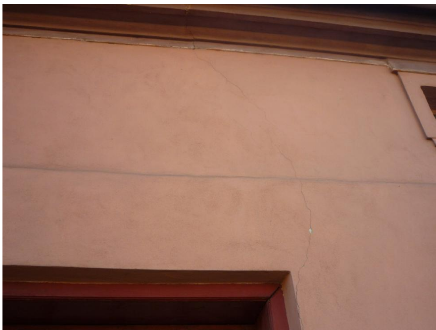
Příloha č. 28 Trhliny ve fasádě (Zdroj: autor, 2016)
