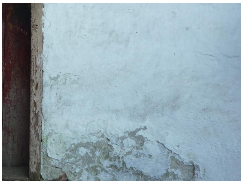
Příloha č. 30 Biogenní porucha fasády (Zdroj: autor, 2016)
