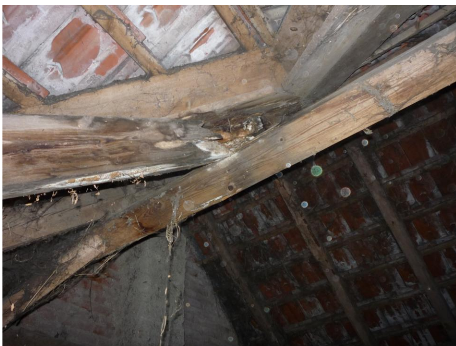
Příloha č. 10 Krokev napadená dřevomorkou domácí (Zdroj: autor, 2016)
