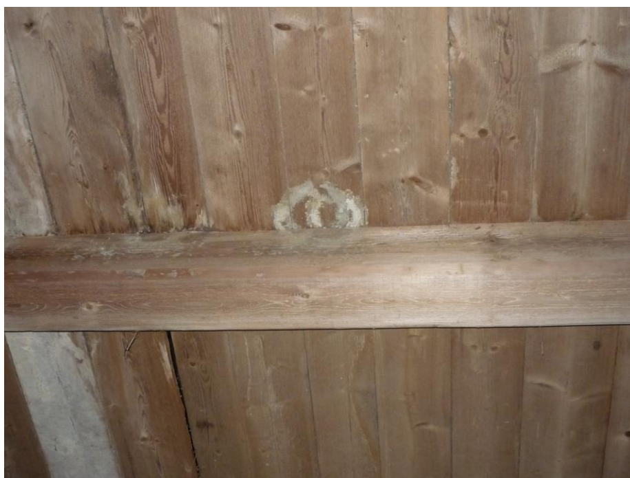
Příloha č. 6 Napadení dřevokaznou houbou (Zdroj: autor, 2016)
