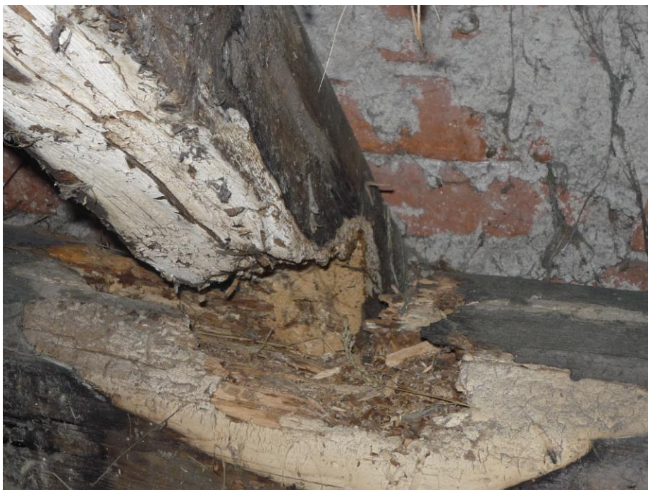
Příloha č. 11 Krokev napadená dřevomorkou domácí (Zdroj: autor, 2016)
