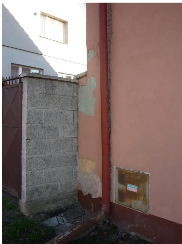
Příloha č. 30 Biogenní porucha fasády (Zdroj: autor, 2016)
