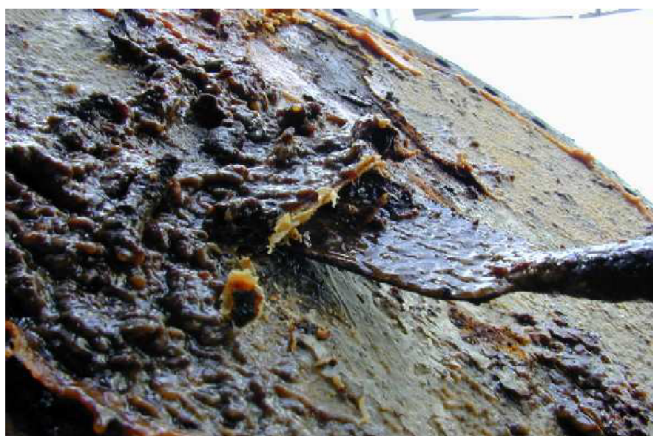
Obr. 6 Odstraňování biologického nánosů [23]
