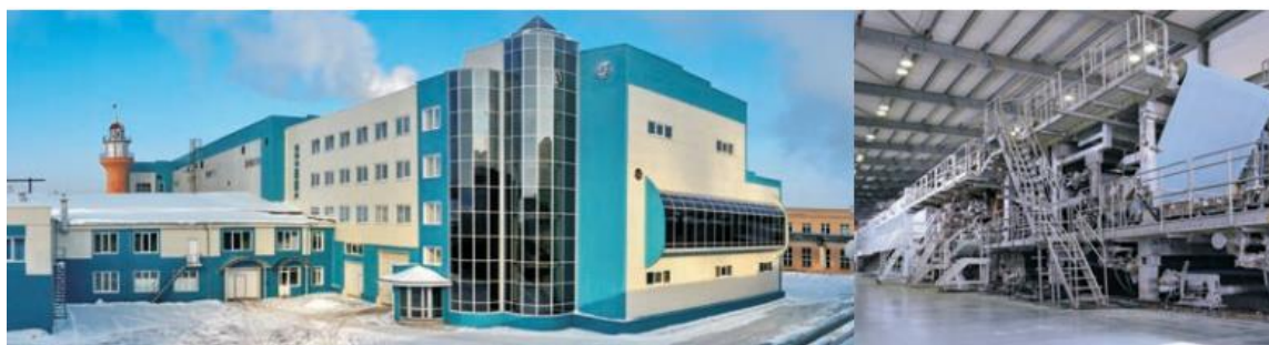
Brown-field projekt - 000 Mayak-Vega, Penza, Rusko: modernizace S/H PS, výstavba ve zcela nových výrobních halách
