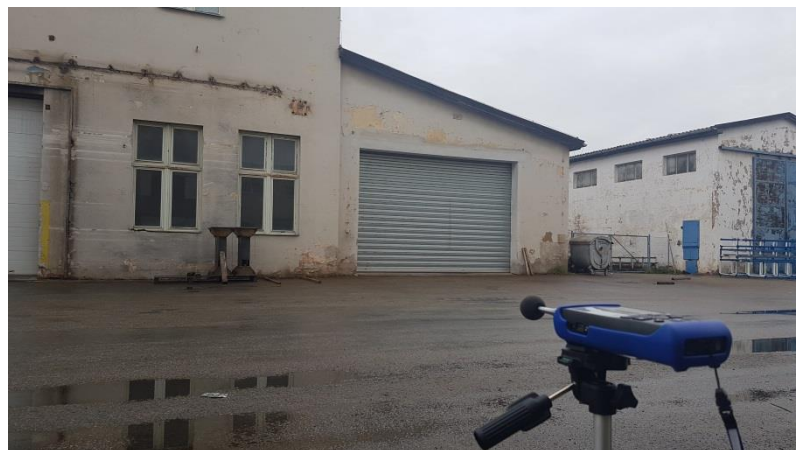
Obr. 29: Pohled na halu A od kancelářské budovy
