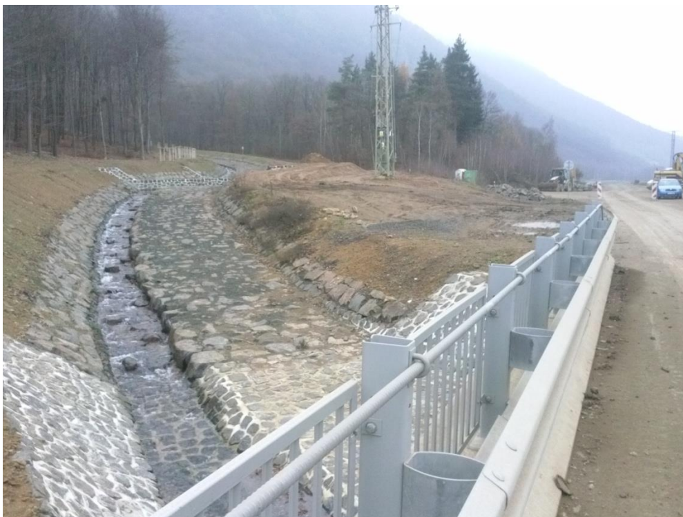
Obr. č. 18, Revitalizace Vesnického potoka s mostem na úpatí Krušných hor. Vpravo viditelná část bývalé silnice Chomutov- Litvínov (Křesálková, 2014).
