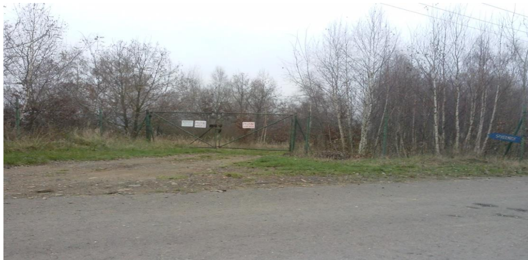
Obr.č.16, Pohled na oplocenou střelnici, nacházející se na vnitřní výsypce lomu ČSA (Křesálková, 2014)
