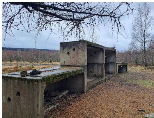
Obrázek 49: Betonové kryty u trhačí jámy na Brdě.
