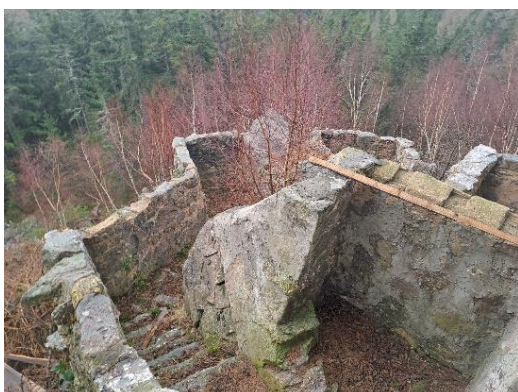
Obrázek 77: Betonový komplex u dělostřelecké pozorovatelny Hřebeny.
