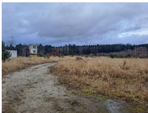
Obrázek 69: Pěchotní střelnice Přední Bahna, v pozadí řídicí věž.
