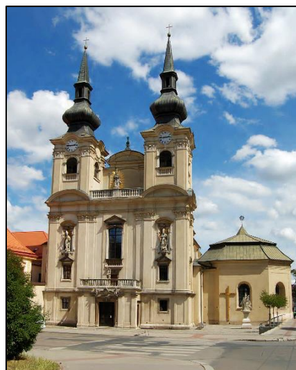
Obr. č. 35 – kostel Nanebevzetí Panny Marie [76]
