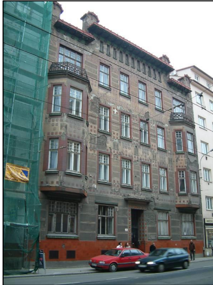
Obr. č. 38 – Průčelí domu ve stylu vídeňské geometrizující secese [74]
