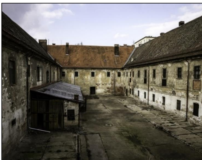
Obr. č. 44 – Objekt bývalé káznice [78]
