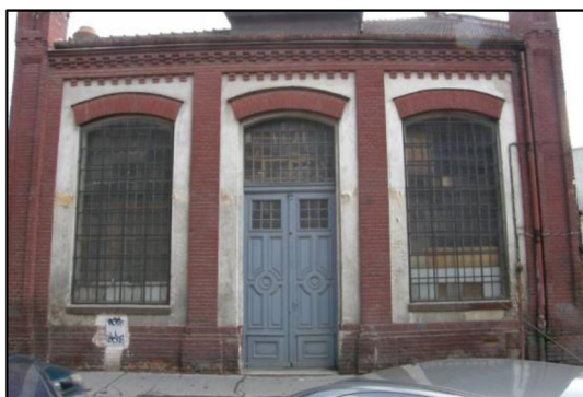
Obr. č. 42 – Bývalá parní elektrárna [74]
