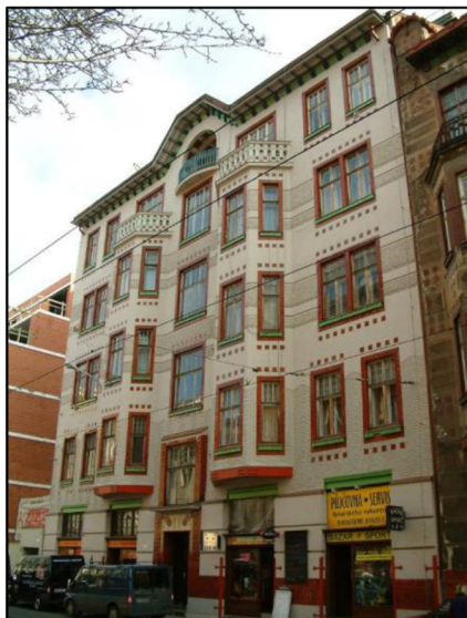
Obr. č. 37 – Průčelí domu ve stylu vídeňské geometrizující secese [74]
