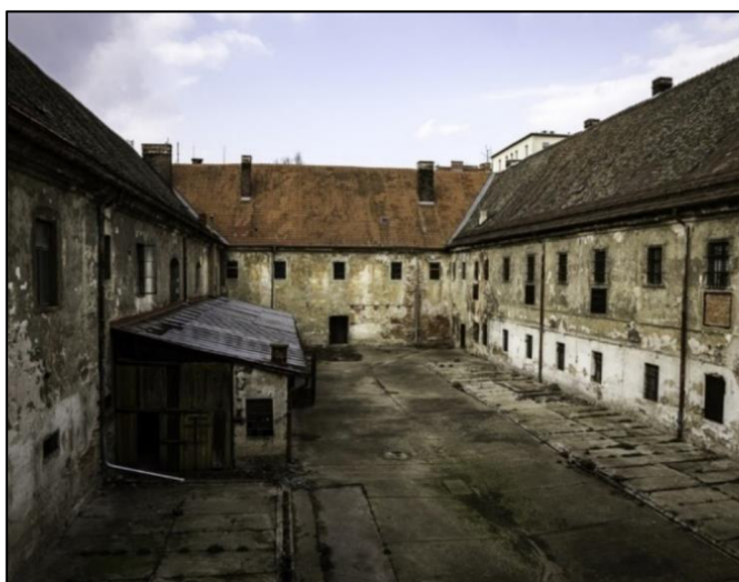
Obr. č. 44 – Objekt bývalé káznice [78]
