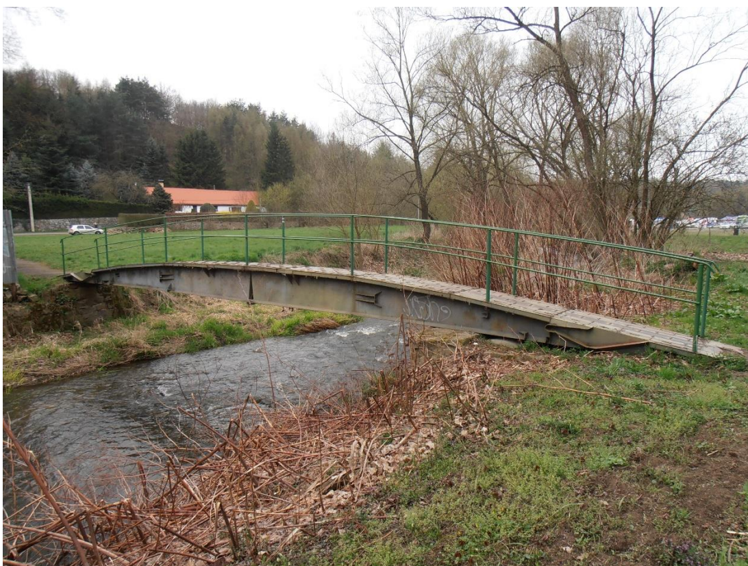
Obr. 4-4: Pontonová lávka - 18,268 ř. km
