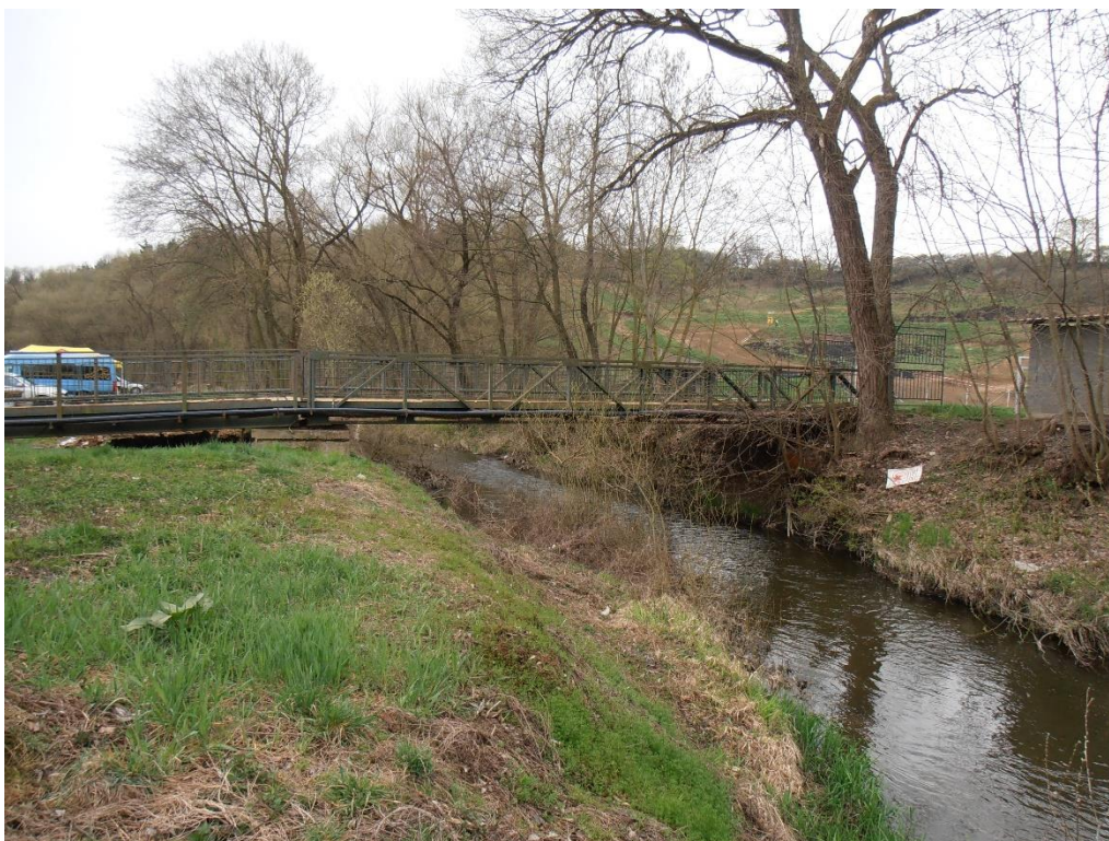
Obr. 4-5: Lávka v Sedlčanské kotlině 17,968 ř. km
