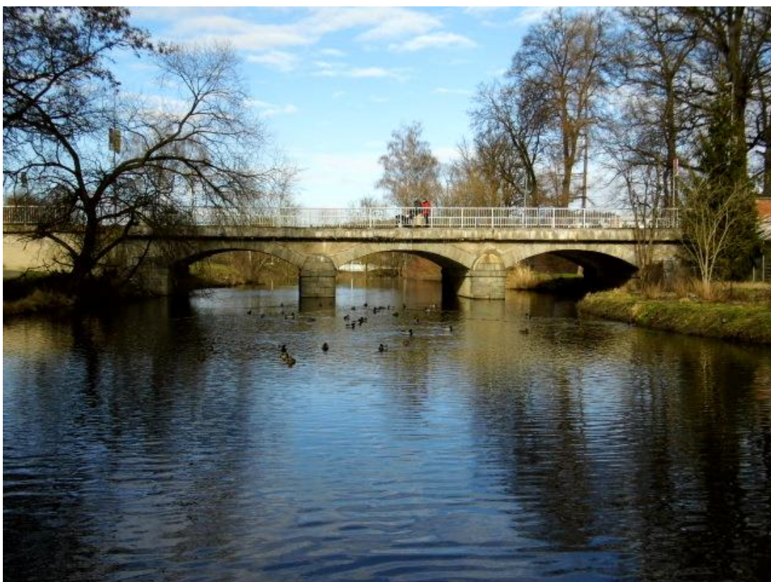
Obr. 4-2: Velký silniční most – 19.555 ř. km
