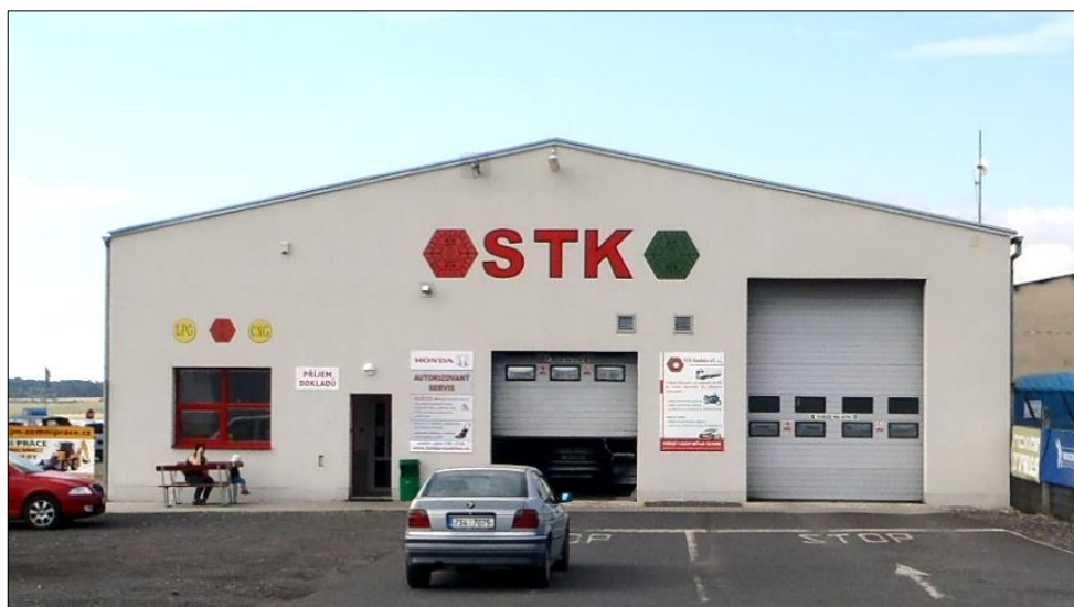
Obrázek 17 - Budova stanice technické a emisní kontroly (78)
