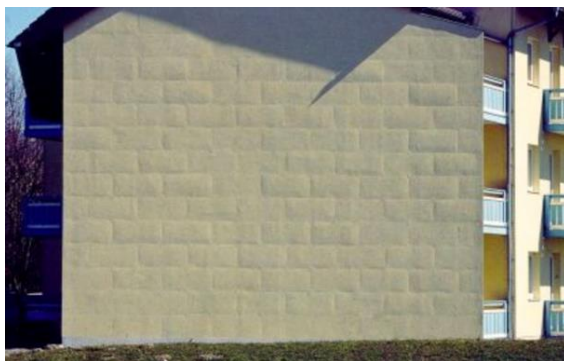
Obrázek 2 – Polštářový efekt vlivem kolísání teplot [3]
