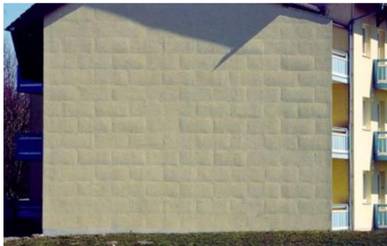
Obrázek 2 – Polštářový efekt vlivem kolísání teplot [3]
