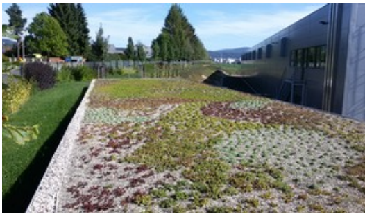
Obrázek 10 Střešní vegetace u výrobního objektu, Jablonec nad Nisou
