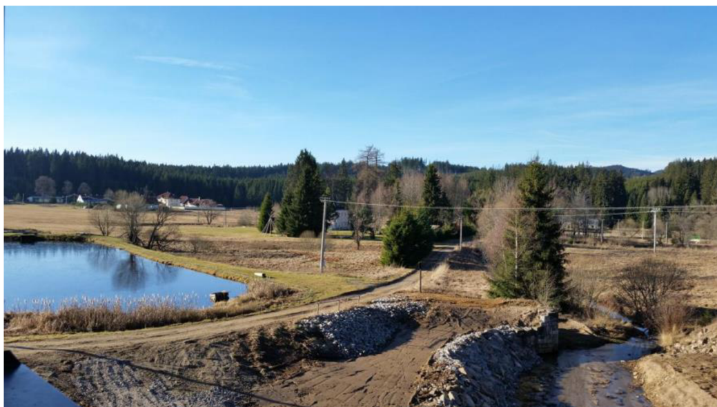
Obrázek 21: Most úzkokolejné dráhy přes Puchěřský potok v Arnoštově, zdroj: František Šotola (2015)
