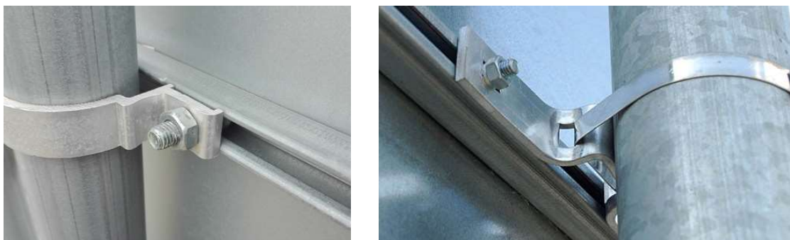
Obrázek 24: Uchycení páskou Bandimex [6]
