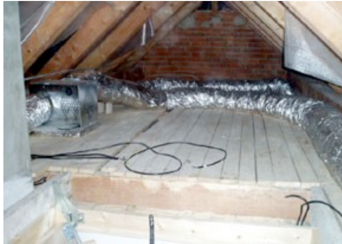
Obr. 1.7 Rozvod tepla v pokrovním prostoru [16]
