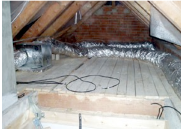
Obr. 1.7 Rozvod tepla v pokrovním prostoru [16]
