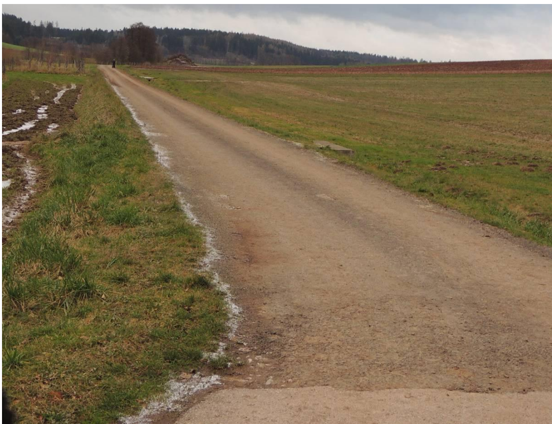
Foto č. 25. Cesta HPC 2 , současný stav (PAULŮ, 2013)
