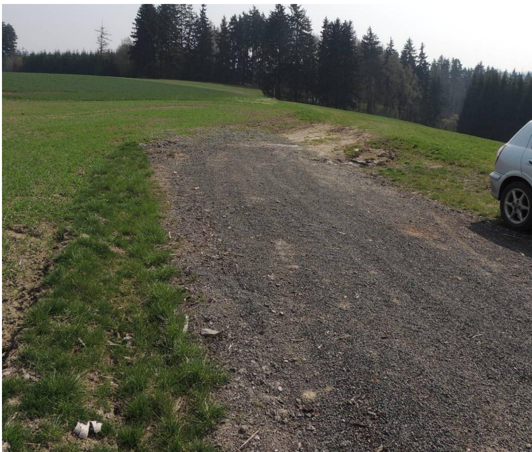
Foto č.33. Cesta VPC 3 , současný stav (PAULŮ, 2013)
