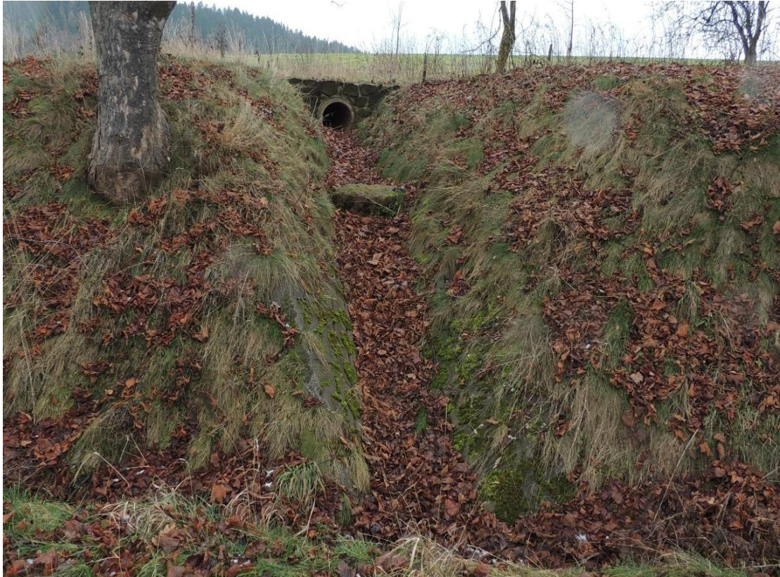
Foto č. 18. PEO 01- propustek a svodný příkop, současný stav (PAULŮ, 2013)
