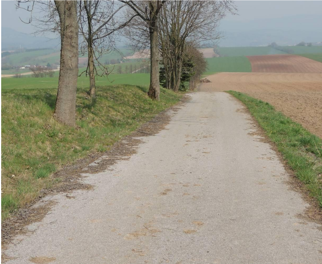
Foto č. 32. Cesta VPC 2 , současný stav (PAULŮ, 2013)
