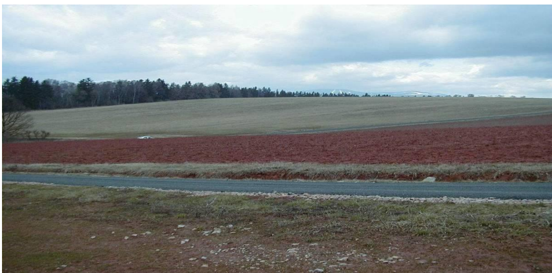
Foto č.13. Cesta VC 15, současný stav (PAULŮ, 2013)
