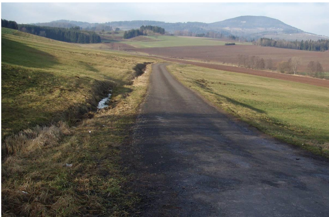
Foto č. 46. Cesta VPC 22 , současný stav (PAULŮ, 2013)
