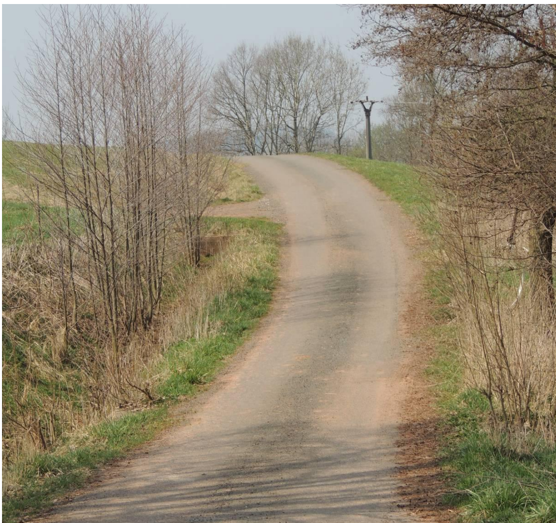
Foto .č.37. Cesta VPC 10 , současný stav (PAULŮ, 2013)
