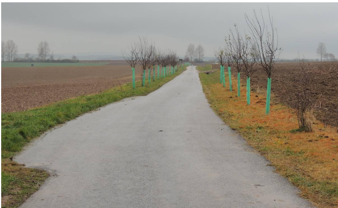
Foto č. 1. Cesta HC 3, současný stav (PAULŮ, 2013)
