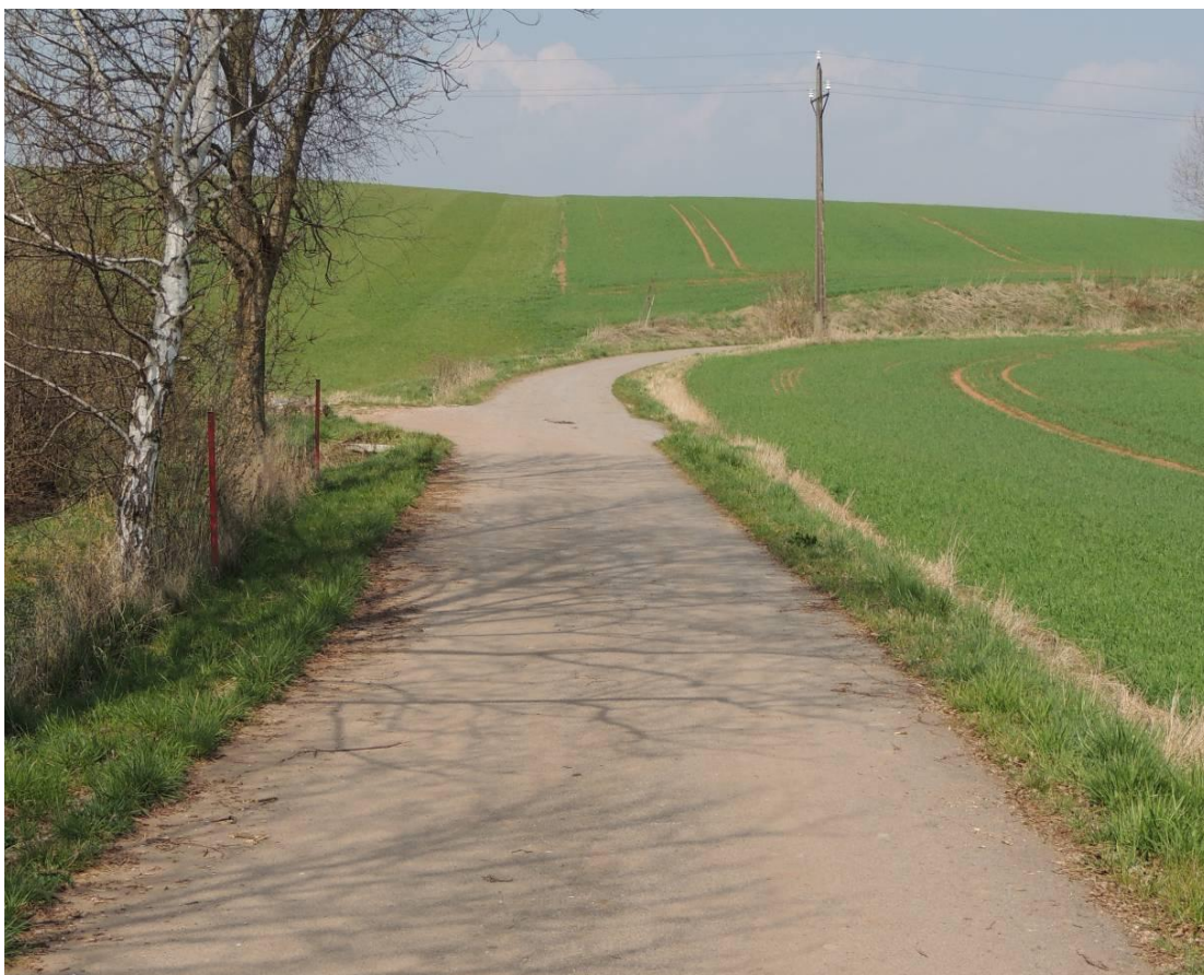
Foto č. 29. Cesta HPC 4 , současný stav (PAULŮ, 2013)
