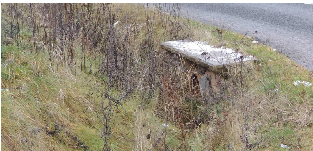
Foto č.20. PEO 02- propustek, současný stav (PAULŮ, 2013)
