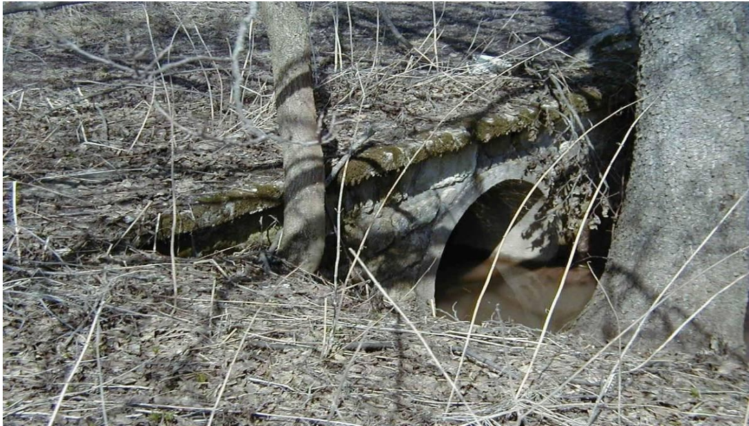
Foto č. 40. Propustek na cestě VPC 14, stav ke dni 28.11 2006 (PŮ TRUTNOV, 2006)
