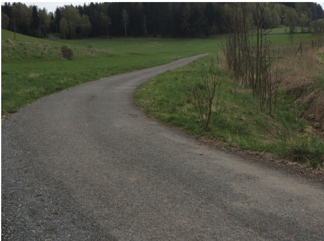
Foto.č. 10. Cesta VC 11, současný stav (PAULŮ, 2013)
