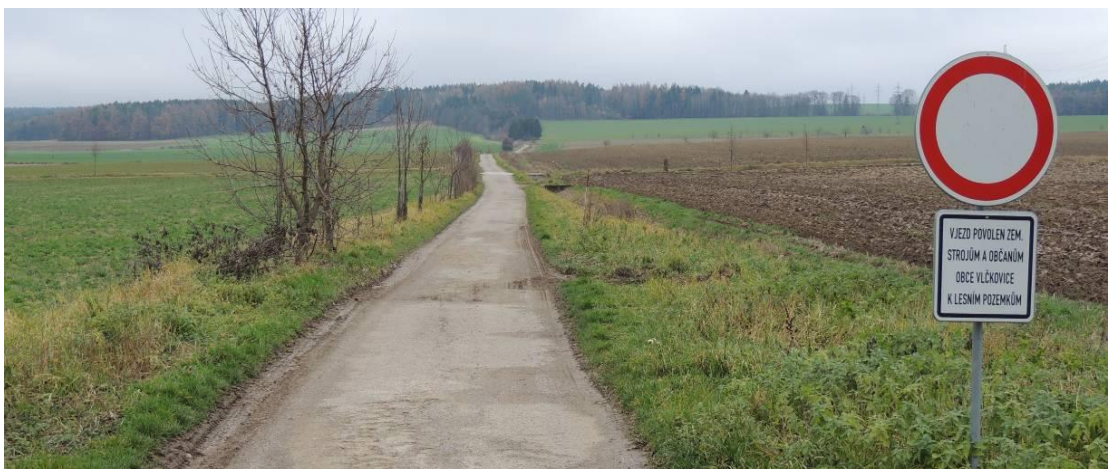
Foto č.50. Cesta C 1.1 , současný stav (PAULŮ, 2013)
