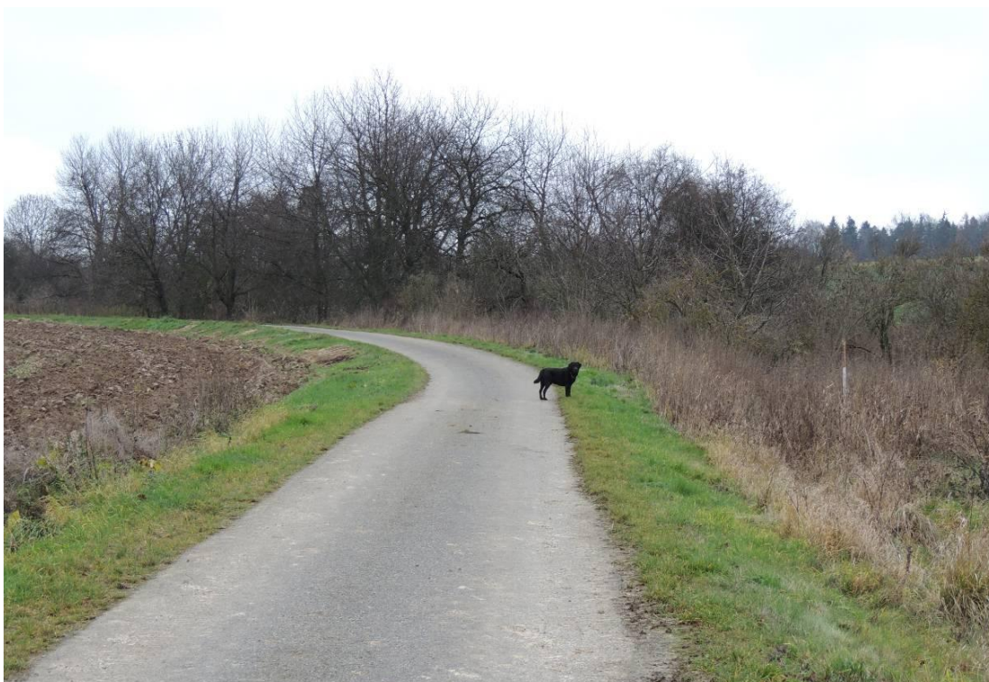
Foto č. 52. Cesta C 2.1 , současný stav (PAULŮ, 2013)
