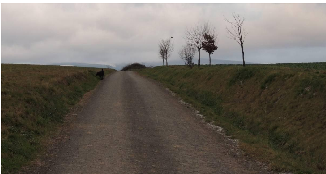
Foto č. 31. Cesta VPC 1 , současný stav (PAULŮ, 2013)
