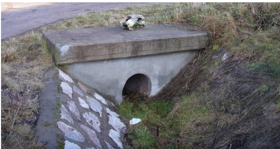
Foto č. 44. Propustek na cestě VPC 17 , současný stav (PAULŮ, 2013)
