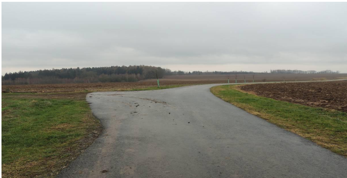
Foto.č. 2. Cesta HC 4, současný stav (PAULŮ, 2013)
