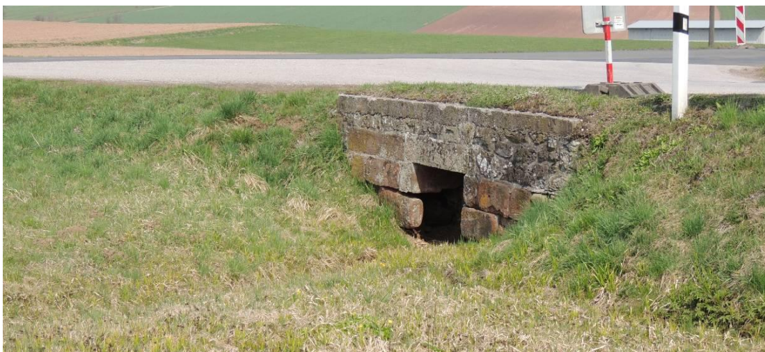
Foto č.34. Mostek na cestě VPC 4 , současný stav (PAULŮ, 2013)
