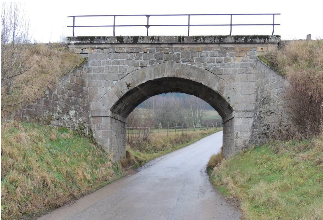
Foto č. 61. Mostek s novou světlostí, současný stav (PAULŮ, 2013)
