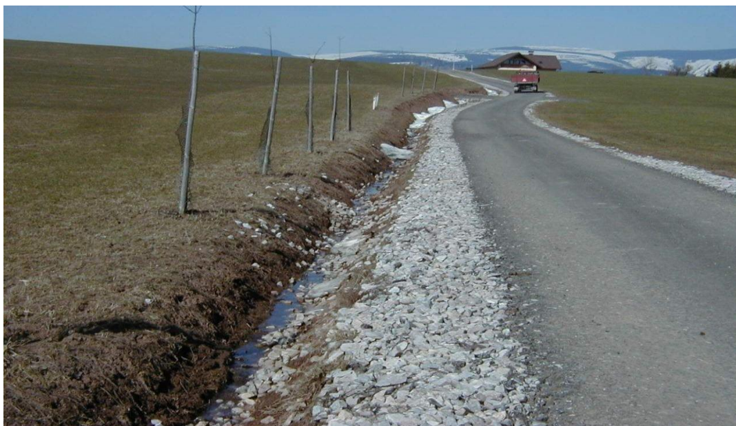
Foto č.22. Cesta HPC 1, stav ke dni 14.11 2006 (PŮ TRUTNOV, 2006)
