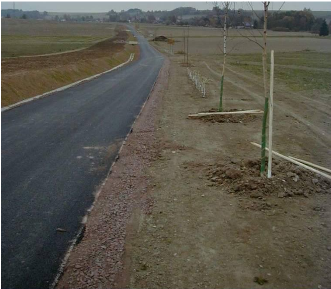
Foto č. 54. Cesta C 2.3, stav k roku 2007 (PÚ TRUTNOV, 2007)
