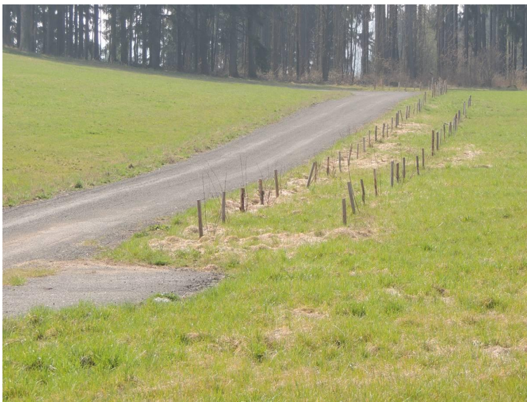
Foto č. 35. Cesta VPC 4 , současný stav (PAULŮ, 2013)
