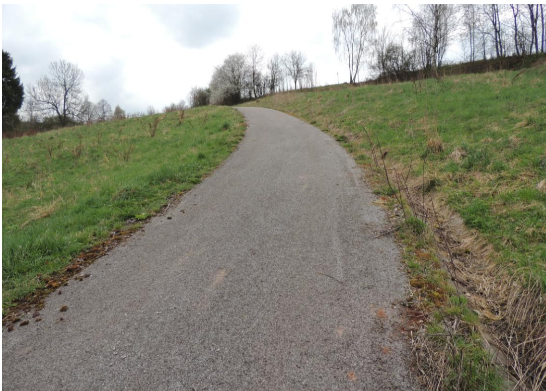
Foto č.10 Cesta VC 13, současný stav (PAULŮ, 2013)
