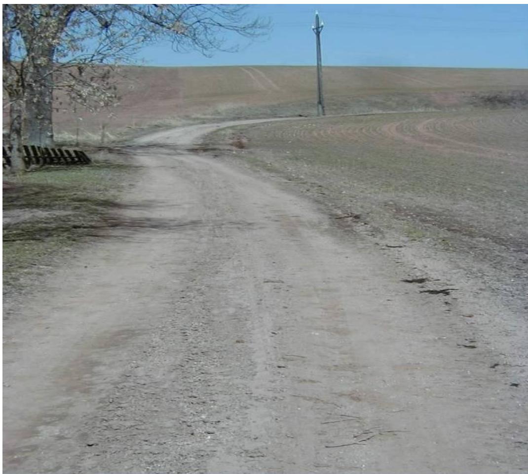
Foto č. 28. Cesta HPC 4, stav ke dni 14.11 2006 (PŮ TRUTNOV, 2006)
