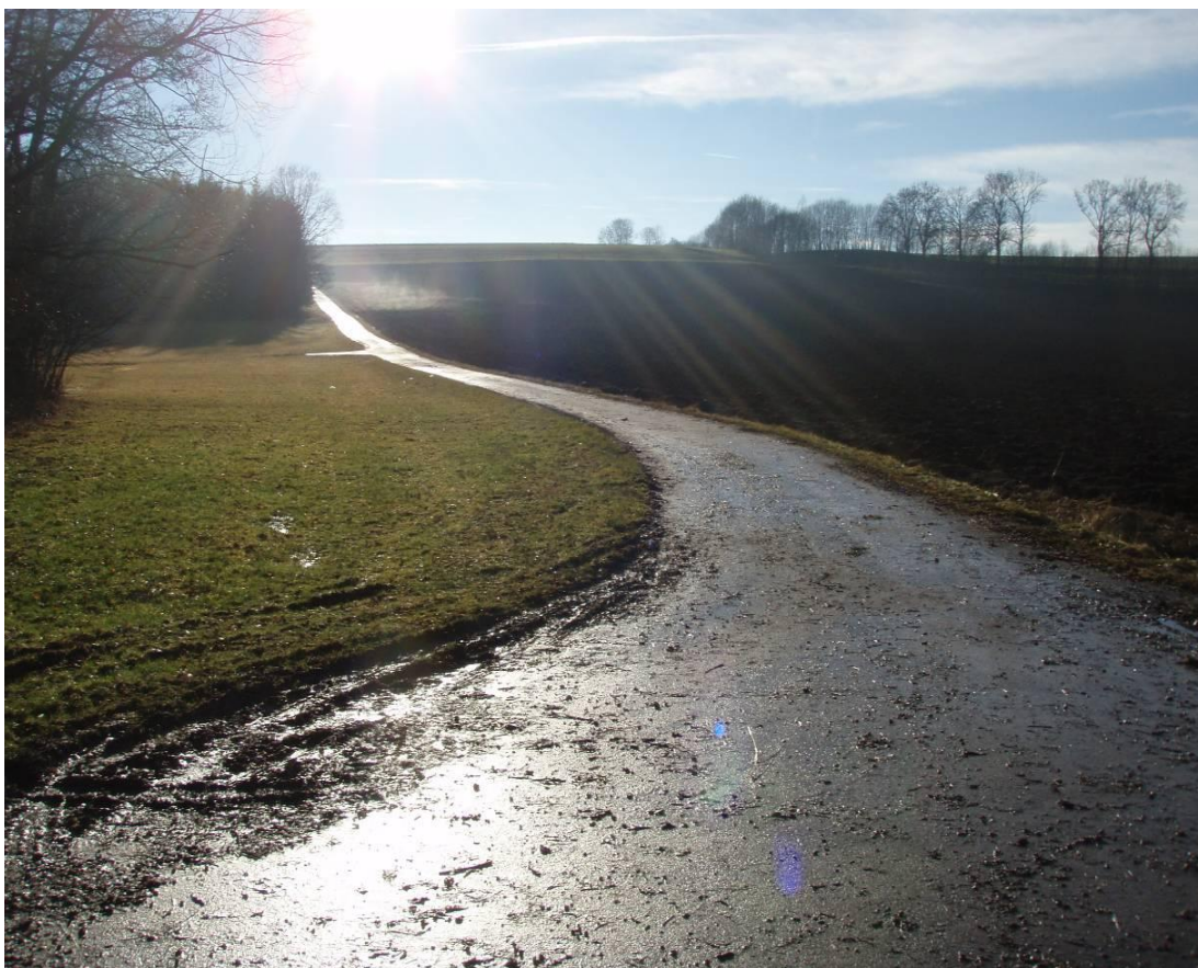
Foto č. 43. Cesta VPC 17 , současný stav (PAULŮ, 2013)
