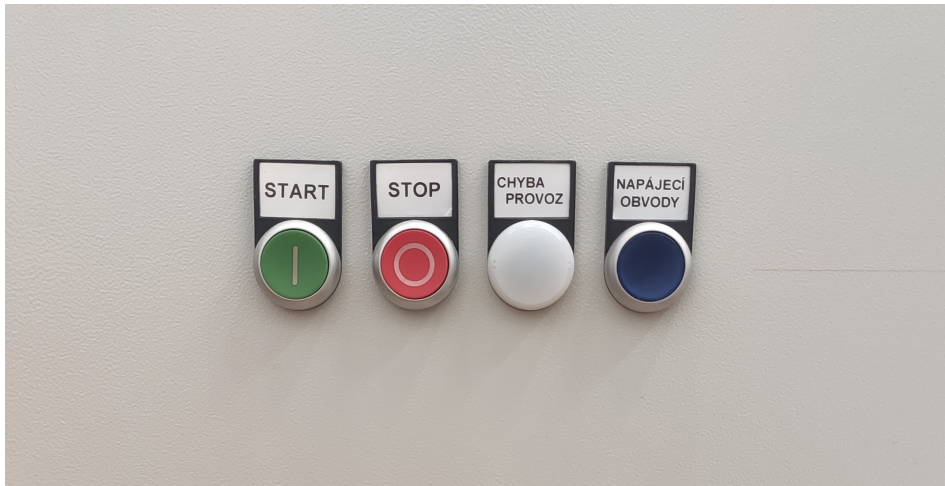
Obrázek 4.3: Ovládací tlačítka na přední straně rozvaděče
