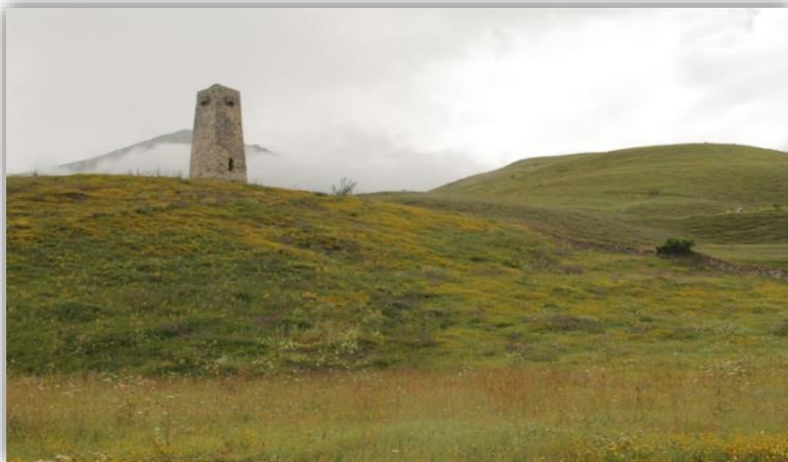
Obr. 8 Ochranná věž. Zdroj: Vlastní foto (2016)
