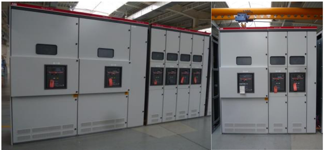
Emaxové rozvaděčové pole
