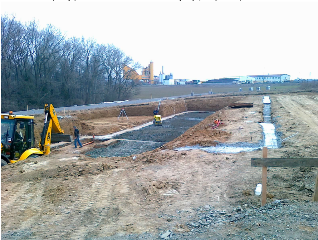
Obrázek 26 - Terénní úpravy pozemku a hloubení základové jámy (zdroj: autor)
