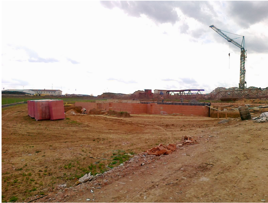
Obrázek 25 - Stav stavby ke dni 7.4.2011 (zdroj: autor)
