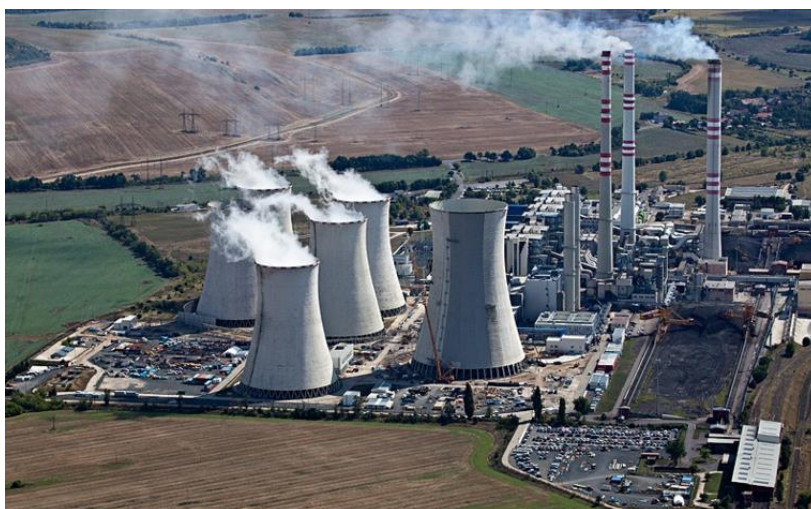
Obrázek 1: elektrárna Počerady ( www.svetenergie.cz )
