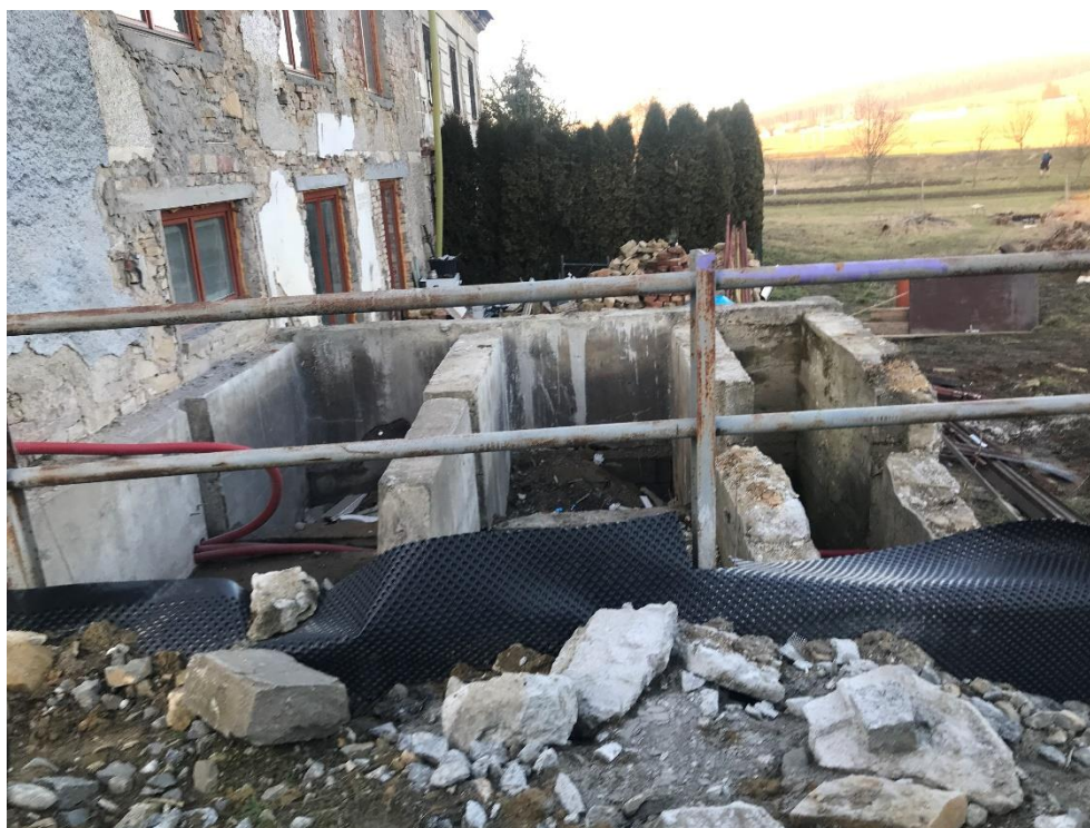
Obr. 36 Pozůstatky turbínové kašny Zdroj: Muchová D., březen 2021
