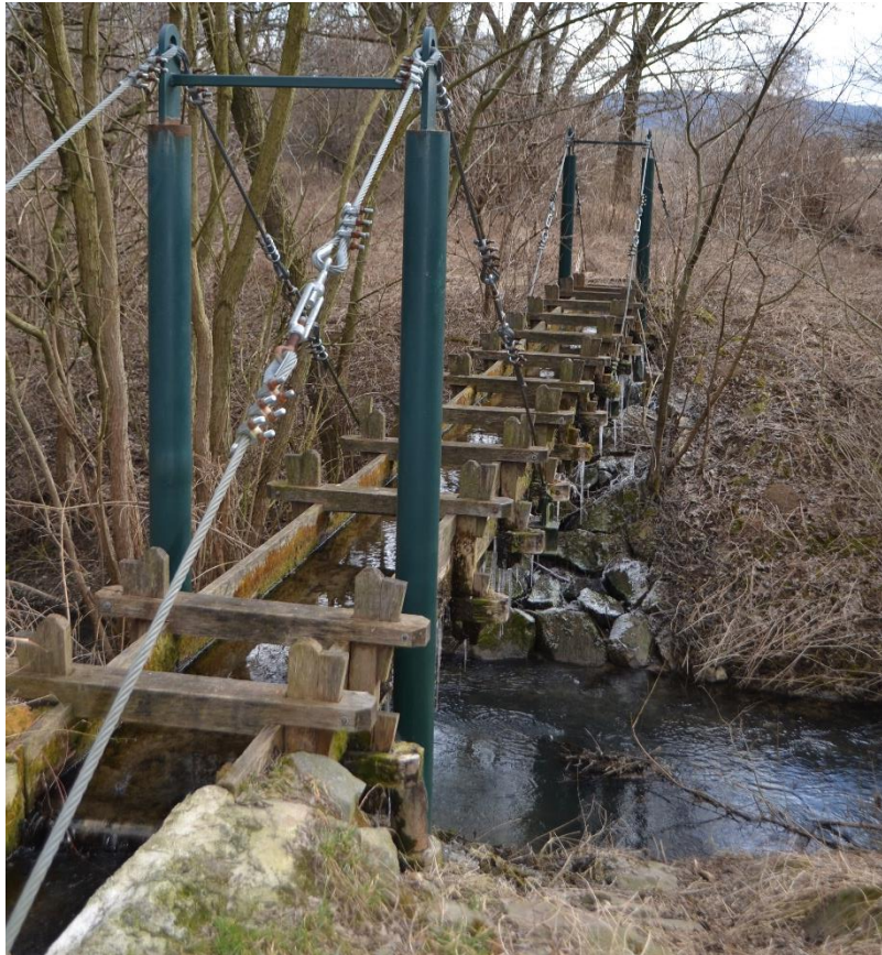
Obr. 31 Zrekonstruovaný akvadukt vedoucí přes Kotojedku Zdroj: Muchová D., březen 2021
