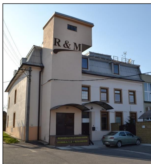
Obr. 101 Bývalý mlýn Kotojedy Zdroj: Muchová D., 2021
