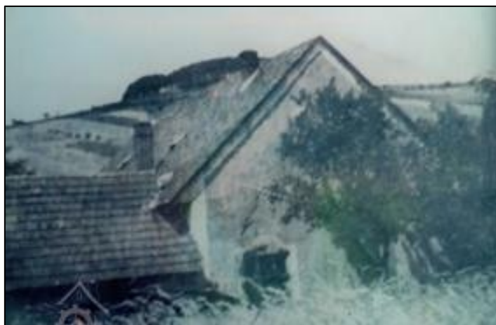
Obr. 23 Krpcův před demolicí v roce 1930
