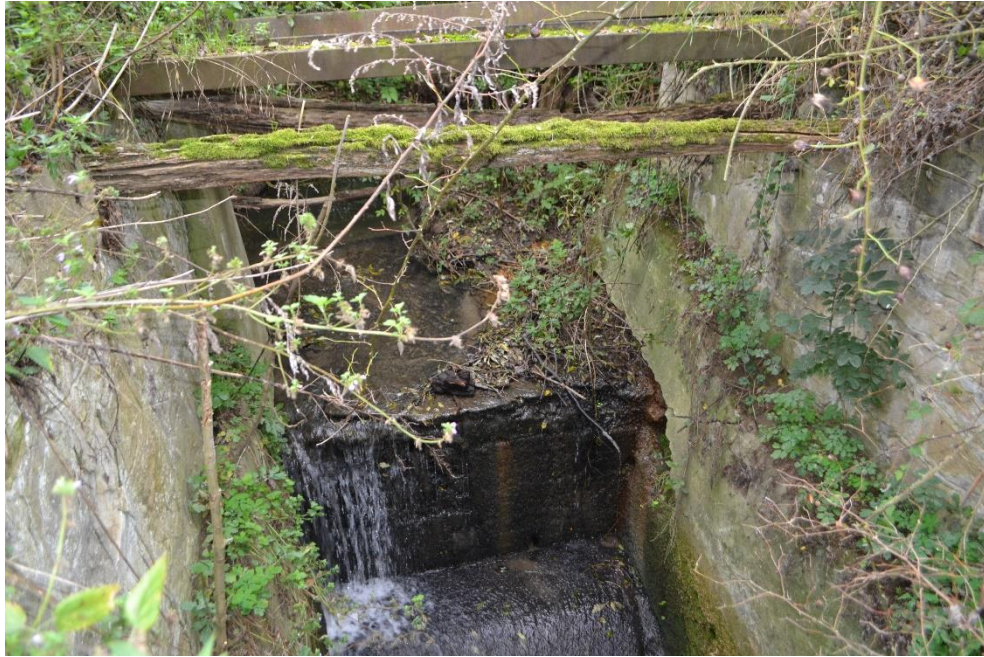
Obr. 3 Zpevněné koryto Kotojedky u Krpcova mlýna Zdroj: Muchová D., březen 2021
