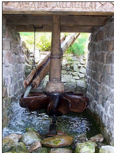
Obr. 12 Horizontální vodní kolo Zdroj: Veselý, 2006
