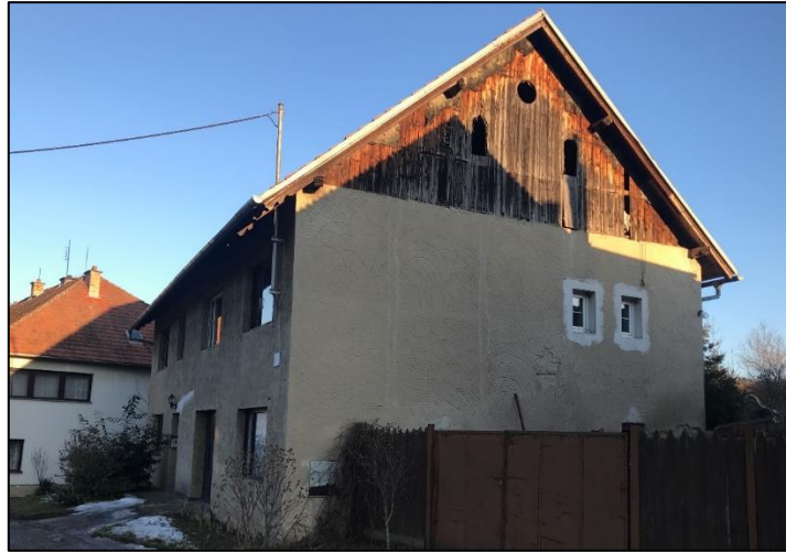
Obr. 73 Bývalý Stratilův mlýn Zdroj: Muchová D., březen 2021
