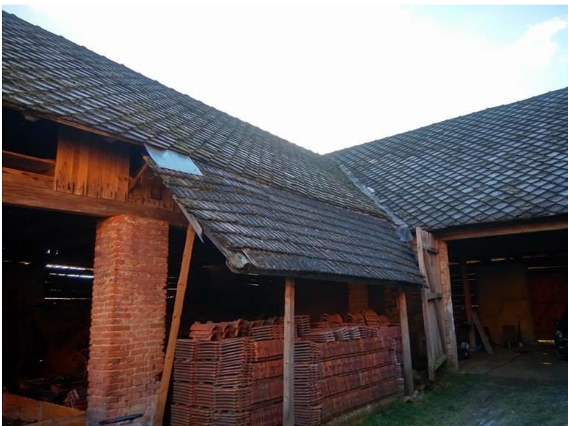
Foto č.4 Pohled na objekt ze dvora
