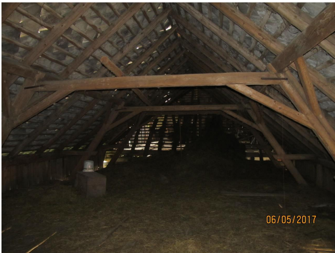
Obr č.6 Kolna krov
