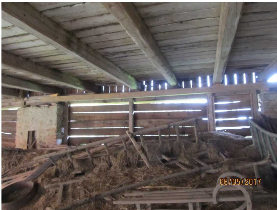
Obr. č.12 Vyztužení průvlaku (Z/Rs1)
