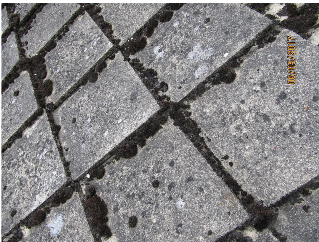
Foto č.2 Stávající krytina
