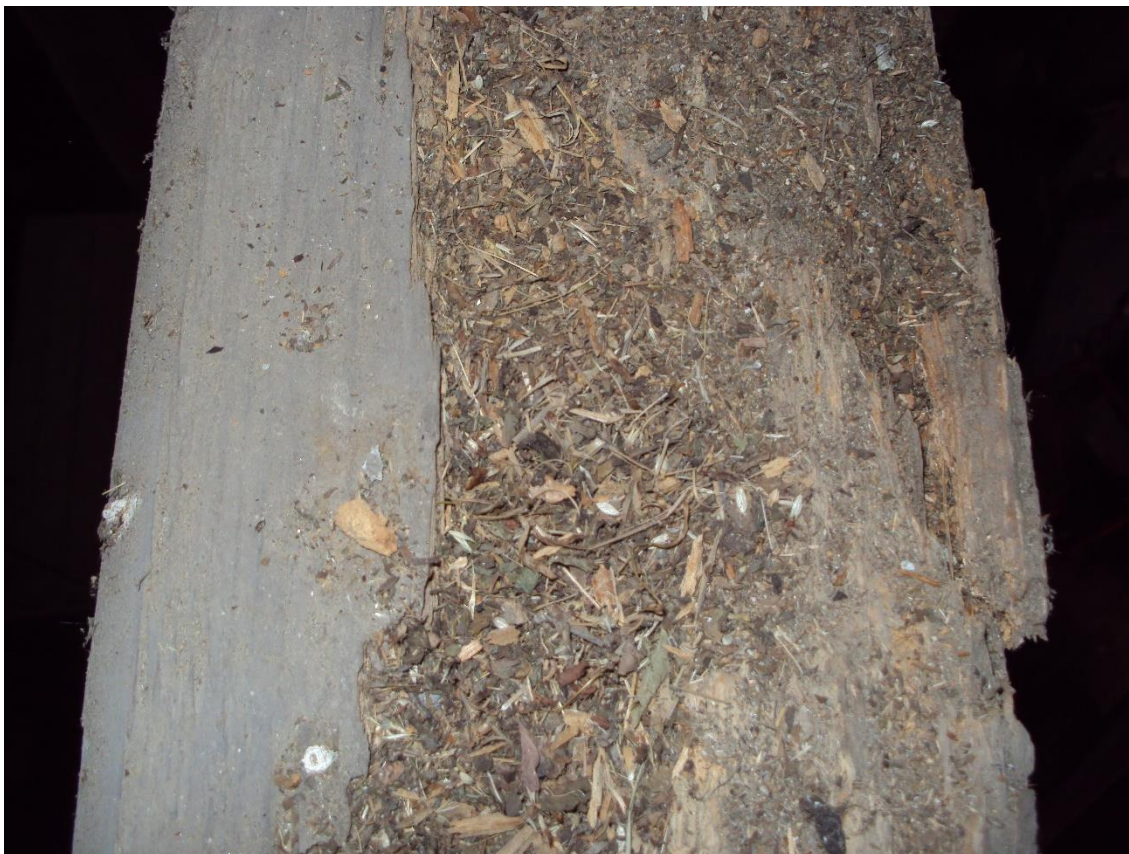
Foto č.12 Použitý stropní trám (D'/ST4)
