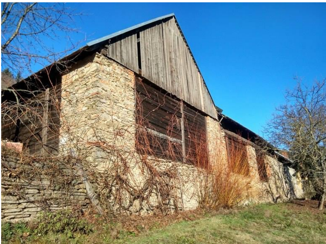
Foto č.3 Pohled na objekt ze zahrady
