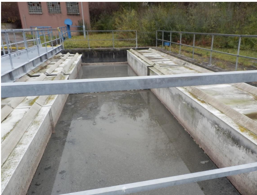
Obrázek 4: Štěrbínové nádrže čistírny odpadních vod FN Motol
