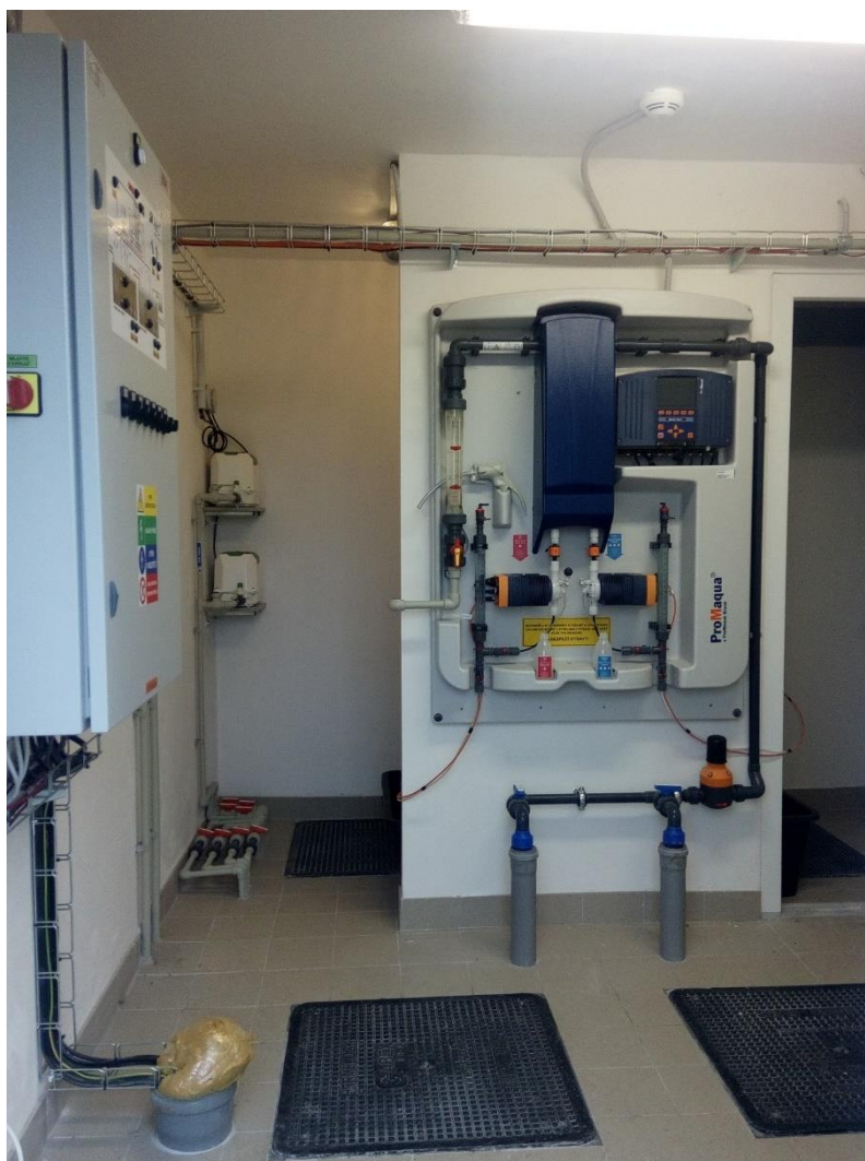
Obrázek 6: Pohled do technologické místnosti, ve které probíhá čištění infekčních vod
