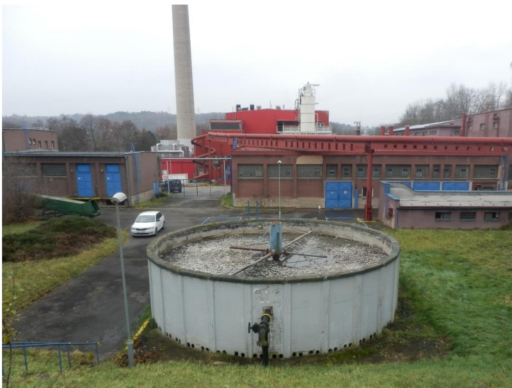
Obrázek 5: Biologický filtr čistírny odpadních vod FN Motol
