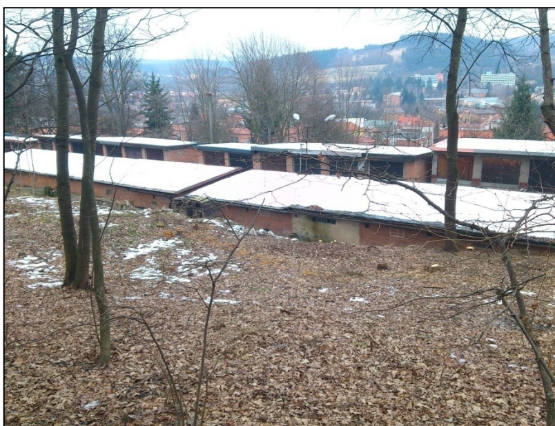
Obr. 3 – Plocha po odstranění skládky
