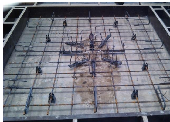
b) Vložení kari sítě a osazení konců
