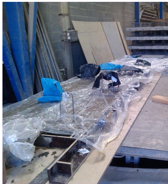
b) Ošetřování betonu po betonáži
