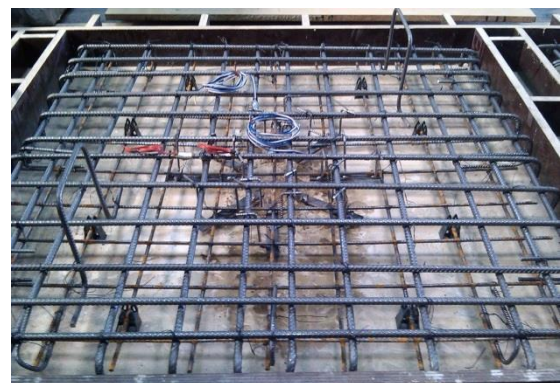
b) Dokončená armatura před betonáží
