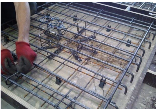
c) Provlékání hlavní ohybové výztuže
