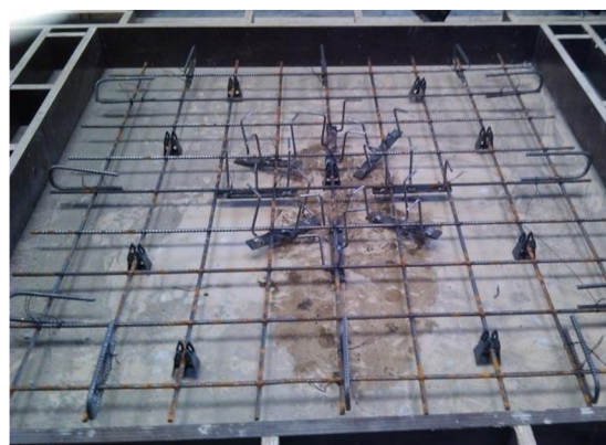
b) Vložení kari sítě a osazení konců
