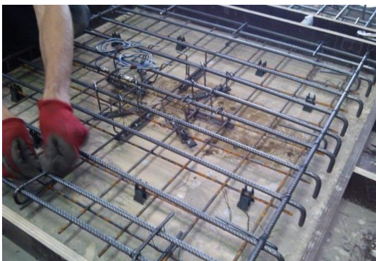
c) Provlékání hlavní ohybové výztuže
