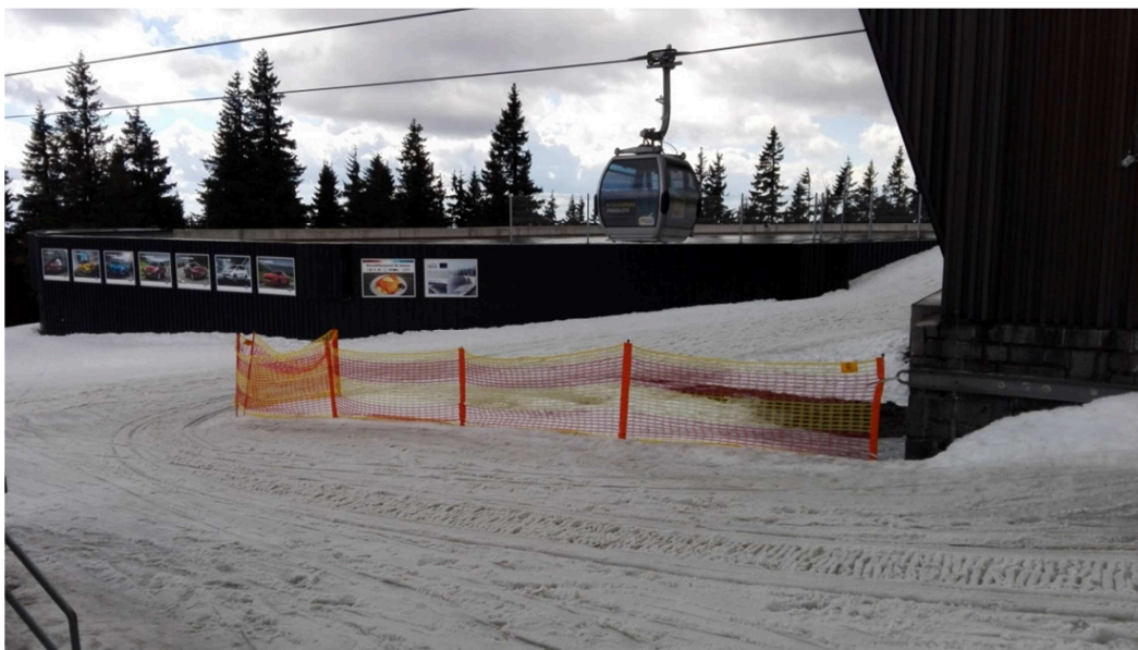
Obrázek 12: Požární a retenční nádrž na Černé hoře v Krkonoších (vlastní fotodokumentace)
