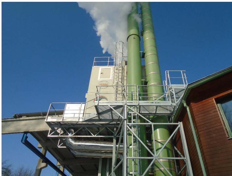
Obr. 12: Venkovní jednotka mokré vypírky spalin (Foto autor, 2020)
