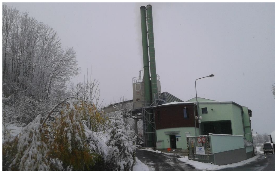
Obr. 2: Výtopna na biomasu v Kašperských Horách (Foto autor, 2019)
