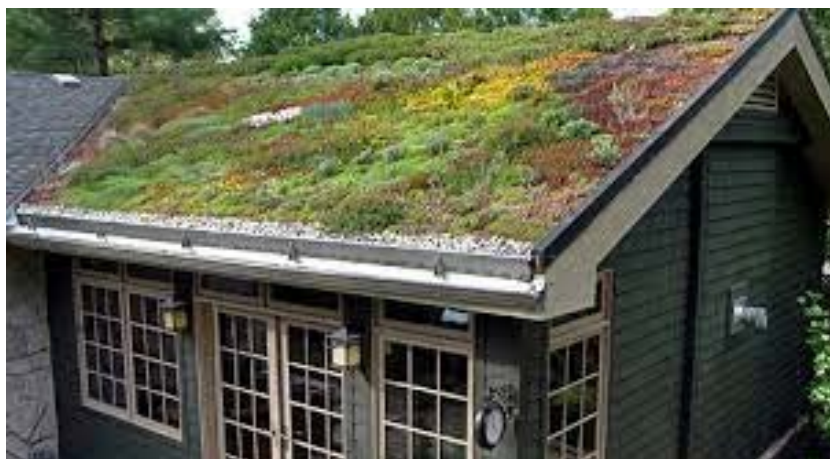
Obr. 6 Zhotovení zelených střech na šikmých střešních rovinách [83]
