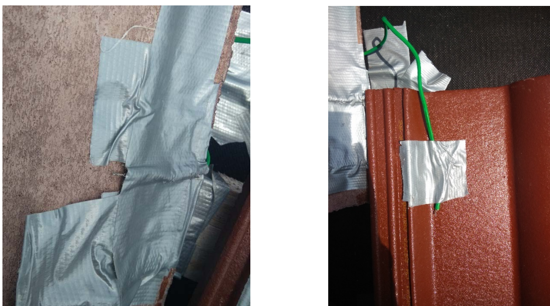
Obr. 22 Umístění termočláneku na spodní a horní stranu krytiny [32]
