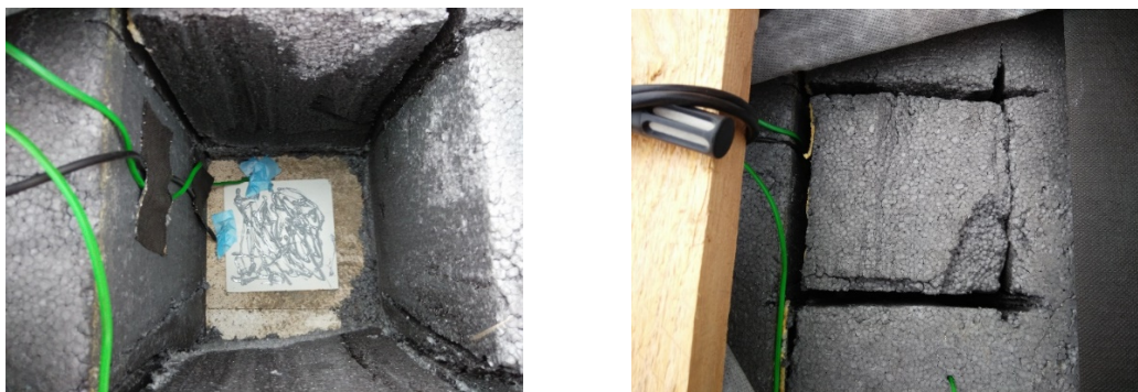
Obr. 19 Provedení sondy skrze tepelný izolant, montáž čidel a zapravení [32]
