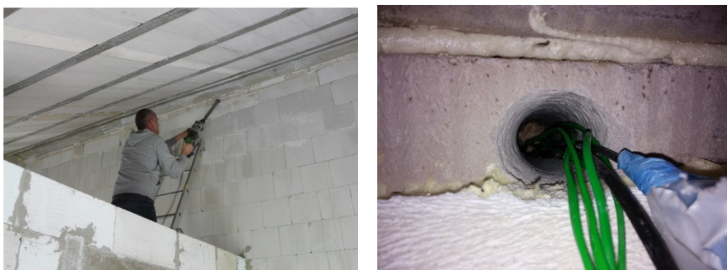
Obr. 18 Provedení místa jádrového vrtu pro instalaci čidel [32]
