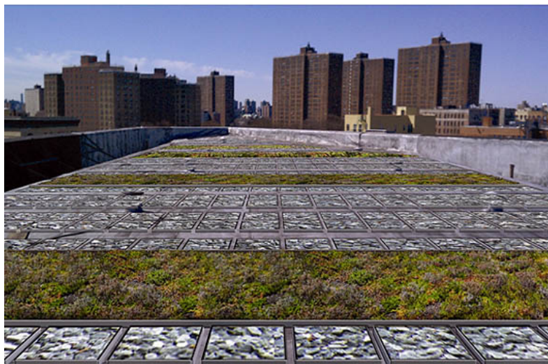
Obr. 7 Zhotovení modrých střech [86]
