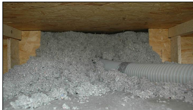
Obr. č. 12 – Izolace z celulózy Isocell (37)
