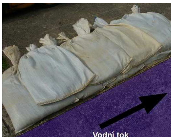
Obrázek č.2: Jednořadé kladení pytlů, zdroj: (11)
