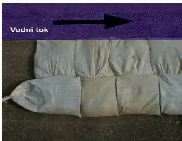
Obrázek č.3: Kombinované víceřadé kladení pytlů, zdroj: (11)
