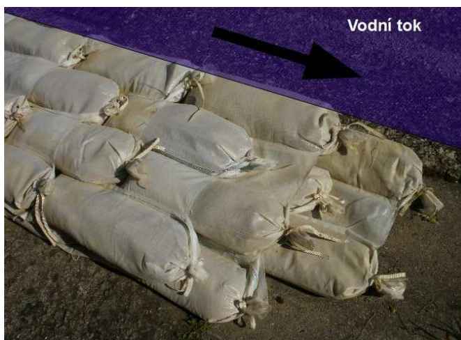
Obrázek č.4: Kladení tandemových pytlů, zdroj: (11)
