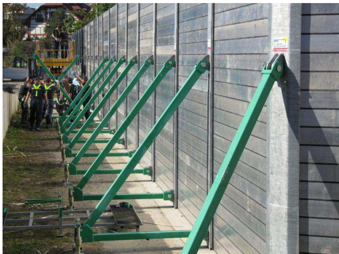
Obrázek č.7: Mobilně stacionární protipovodňové hrazení, zdroj: (20)
