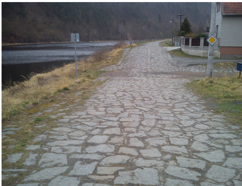
Obrázek č.12: Současný stav křížení hlavní obslužné komunikace s místní komunikací u č.p.51, zdroj: vlastní výzkum
