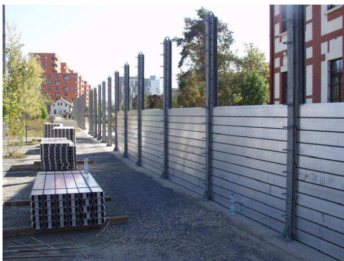
Obrázek č.6: Mobilně stacionární protipovodňové hrazení, zdroj: (20)
