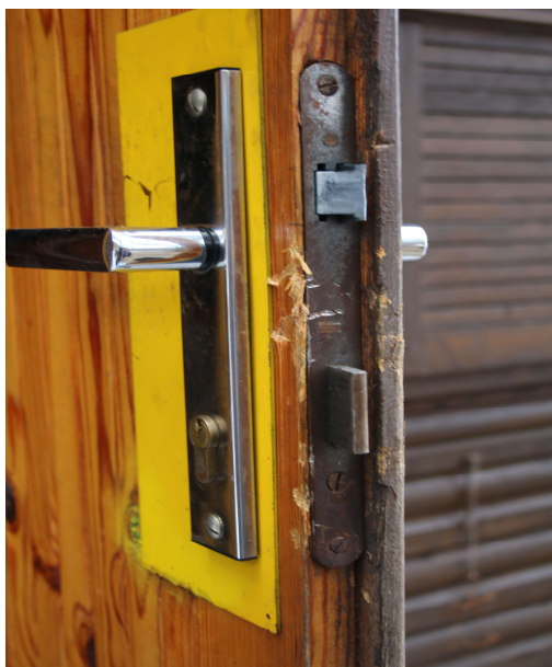
Obr. č. 34: Pohled na zámek vypáčených dveří – vlastní obrázek. Zdroj: (kriminalistický spis KŘP Havlíčkův Brod).
