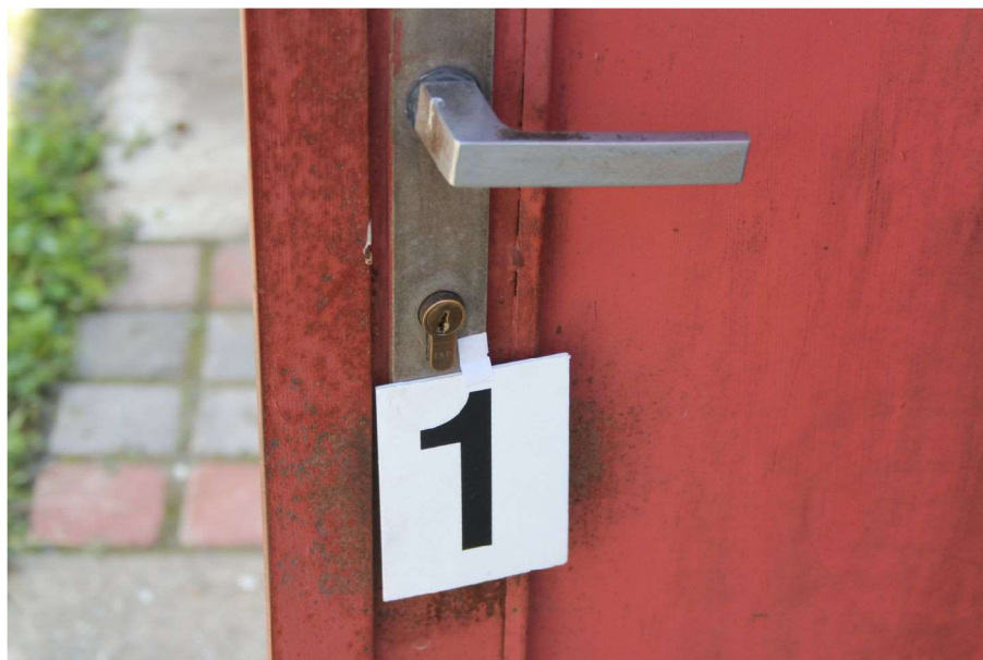
Obr. č. 23: Pohled na zámek dveří s cylindrickou vložkou – vlastní obrázek. Zdroj: (kriminalistický spis KŘP Havlíčkův Brod).
