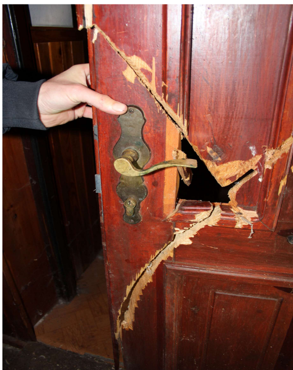
Obr. č. 35: Pohled na vyříznutý zámek z části dveří – vlastní obrázek. Zdroj: (kriminalistický spis KŘP Havlíčkův Brod).
