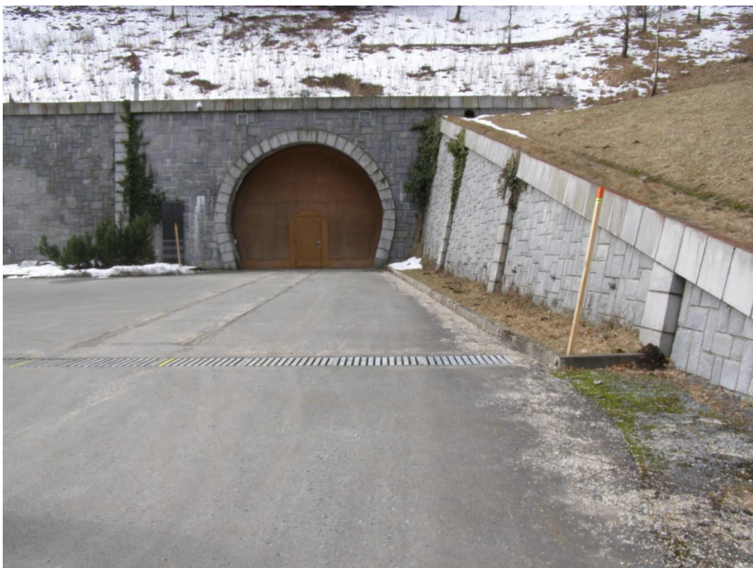
Příloha č. 3. Vchod do podzemní elektrárny (Zdroj: Autor)
