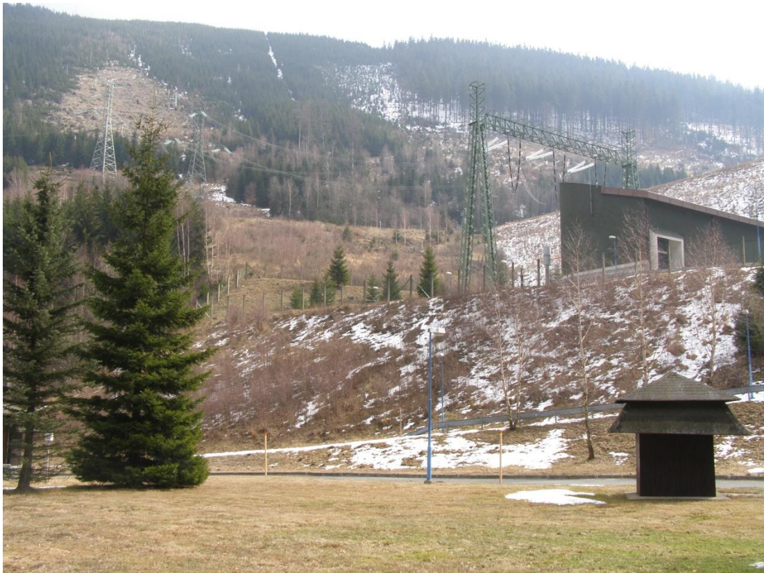
Příloha č. 5. Zapouzdřená rozvodna a venkovní vedení 400 kV (Zdroj: Autor)
