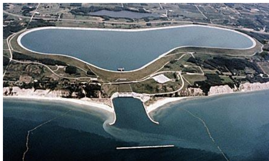
Obr. č. 20. Přečerpávací vodní elektrárna Ludington (URL 18)
