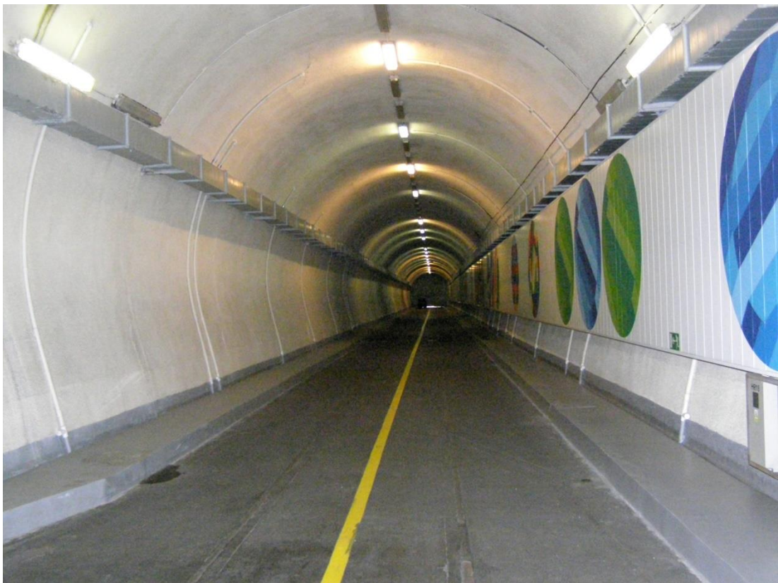
Příloha č. 6. Podzemní tunel k podzemní elektrárně (Zdroj: Autor)
