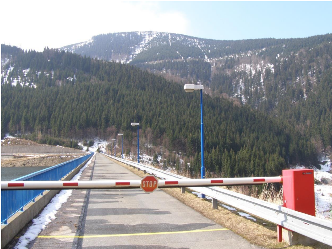
Příloha č. 7. Koruna hráze dolní nádrže (Zdroj: Autor)
