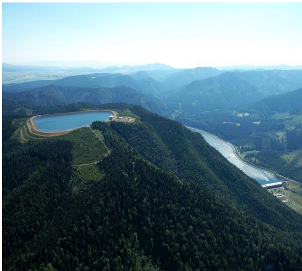
Obr. č. 21, Přečerpávací vodní elektrárna Čierny Váh (URL 19)
