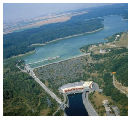
Obr. č. 14, Přečerpávací vodní elektrárna Dalešice (URL 13)
