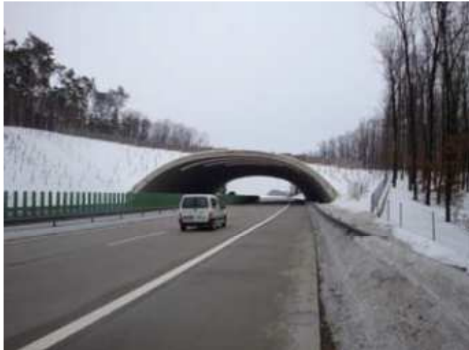
Obr. 2: Příklad mostu s dostatečnými technickými parametry pro kategorii A, Nadchod na dálnici D11 (km 70,5), (Anděl a kol, 2011).
