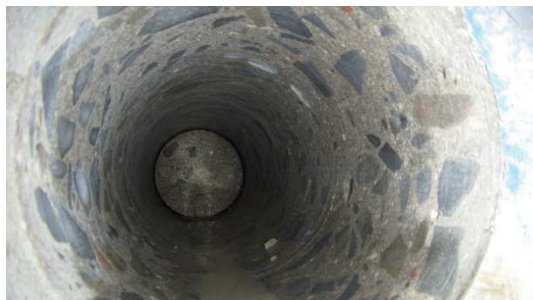
Obrázek P2. 41: Pohled do provedeného vývrtu v pilíři (sonda VO1)
