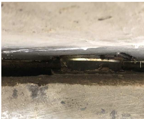
Obrázek 28: Detail hrncového ložiska na OP1, levá strana mostu [41]
