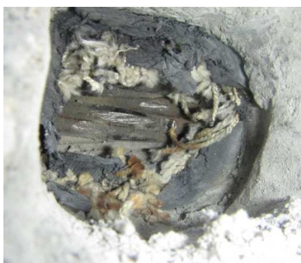
Obrázek 39: Detail otevřené pryžové chráničky v místě spoje nosníků [42]
