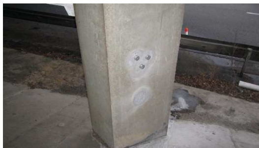
Obrázek P2. 35: Pohled na zkušební místo PP2 s nalepenými zkušebními terči
