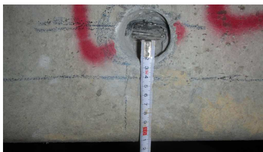
Obrázek P3. 38: Délka provedeného vrtu na sondě K-10
