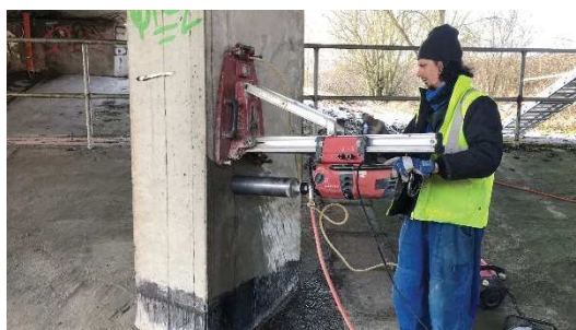
Obrázek P2. 29: Postup odběru jádrového vývrtu VP2 z mostního pilíře
