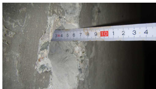
Obrázek P3. 34: Délka provedeného vrtu na sondě K-9
