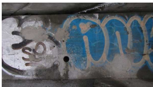
Obrázek P2. 39: Pohled na zkušební místo VO1 (opěra OP1)
