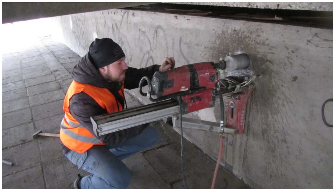
Obrázek 36: Postup odebrání jádrového vývrtnu z opěry OP4 [42]
