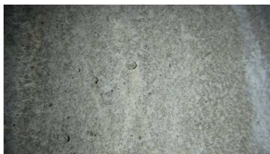
Obrázek P2. 22: Makrotextura betonu uvnitř komory 2. nosníku 1/2
