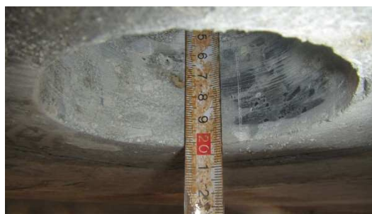
Obrázek P2. 10: Délka odvrtné sondy VN2
