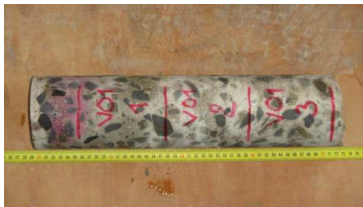
Obrázek P2. 42: Laboratorní foto jádrového vývrtu VO1 s provedenou fenolftaleinovou zkouškou a naznačeným příčným dělením na zkušební vzorky
