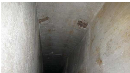
Obrázek P2. 15: Pohled do komory 5. nosníku 2/3
