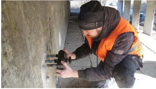
Obrázek P2. 51: Provádění odtrhové zkoušky pomocí automatického trhacího přístroje Proceq DYNA DY-16
