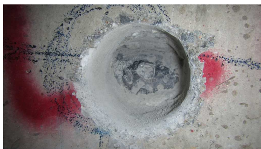
Obrázek P3. 39: Detail stavu chráničky – sonda K-10
