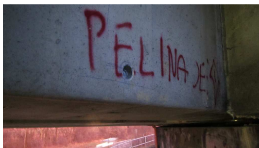
Obrázek P3. 37: Pohled na zkušební místo na stěně nosníku (sonda K-10)
