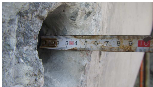
Obrázek P3. 14: Délka provedeného vrtu na sondě K-4
