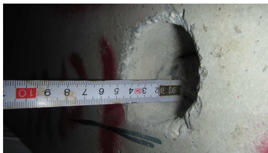
Obrázek P3. 30: Délka provedeného vrtu na sondě K-8
