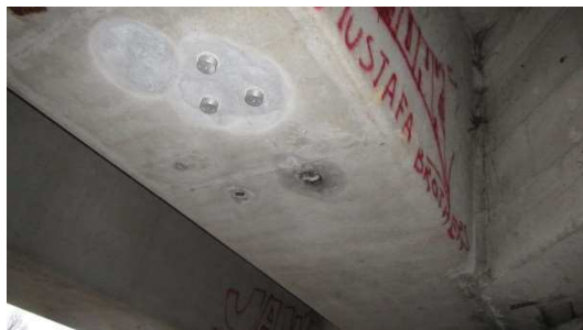
Obrázek P2. 25: Úprava zkušebního místa PN1 s nalepenými zkušebními terči
