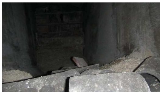
Obrázek P2. 6: Pohled do komory 4. nosníku 2/4
