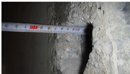
Obrázek P3. 22: Délka provedeného vrtu na sondě K-6
