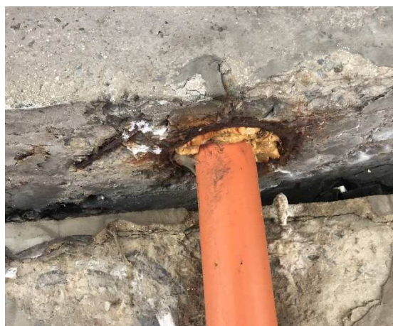
Obrázek 33: Detail napojení vyústění mostních odvodňovačů, původní litinový svod je nahrazen rourou z PVC [41]
