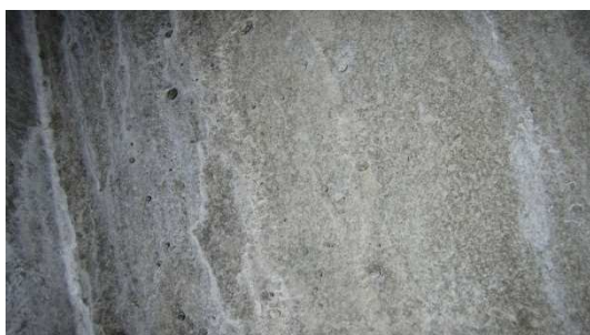
Obrázek P2. 23: Makrotextura betonu uvnitř komory 2. nosníku 2/2
