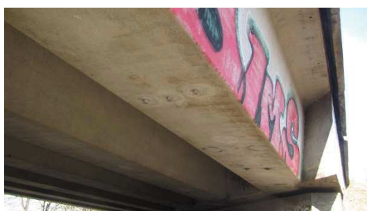
Obrázek P2. 27: Zkušební místo PN3s nalepenými zkušebními terči
