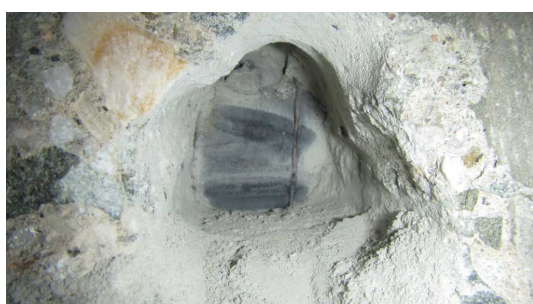
Obrázek P3. 35: Detail stavu chráničky – sonda K-9
