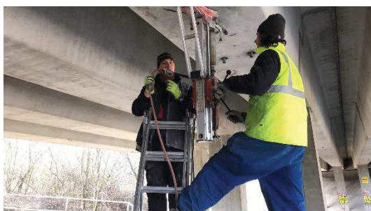
Obrázek P2. 1: Postup odběru jádrového vývrtu VN1 ze spodní příruby nosníku č. 4
