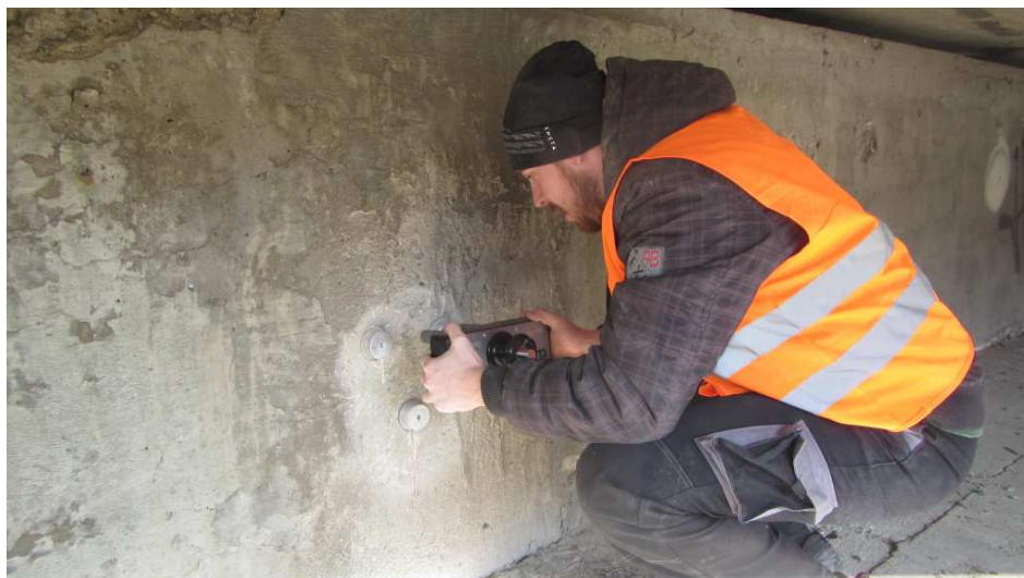
Obrázek 37: Postup provádění odtrhových zkoušek na betonovém povrchu opěry OP4 [42]
