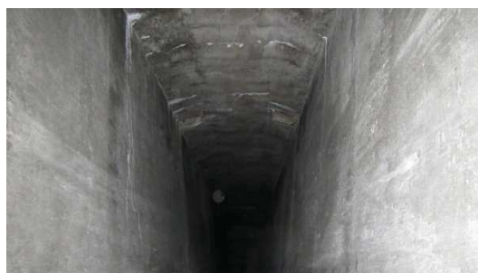
Obrázek P2. 24: Pohled do komory 2. nosníku 2/2
