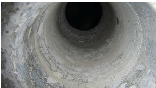
Obrázek P2. 19: Pohled na zkušební místo VN3 (nosník č. 2)
