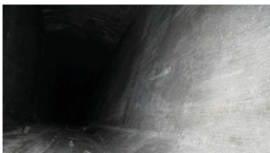
Obrázek P2. 21: Pohled do komory 2. nosníku 1/2
