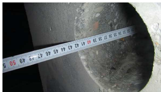
Obrázek P2. 32: Hloubka provedeného jádrového vývrtu VP3
