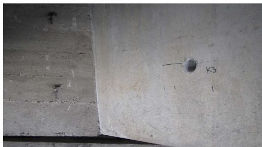
Obrázek P3. 9 : Pohled na zkušební místo na stěně nosníku (sonda K-3)
