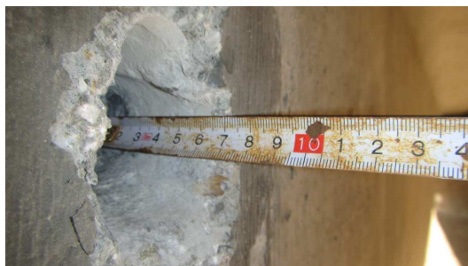
Obrázek P3. 18: Délka provedeného vrtu na sondě K-5
