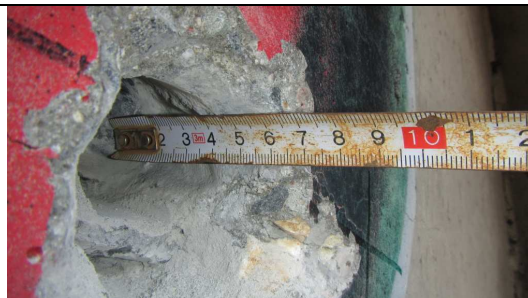
Obrázek P3. 2: Délka provedeného vrtu na sondě K-1
