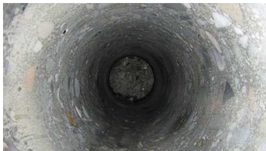
Obrázek P2. 33: Pohled do provedeného vývrtního otvoru v pilíři (sonda VP3)
