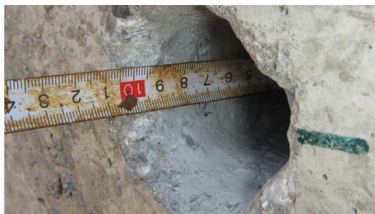
Obrázek P3. 6: Délka provedeného vrtu na sondě K-2
