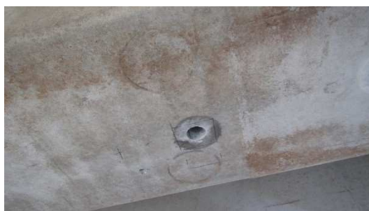
Obrázek P2. 9: Pohled na zkušební místo VN2 (nosník č. 5)
