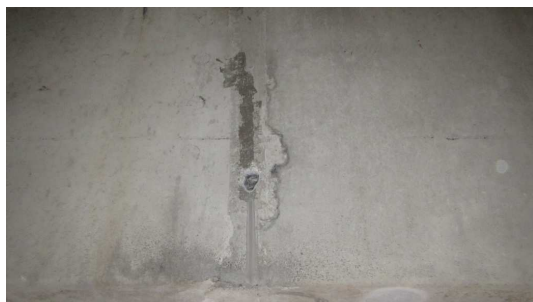
Obrázek P3. 21: Pohled na zkušební místo na ozubu nosníků (sonda K-6)
