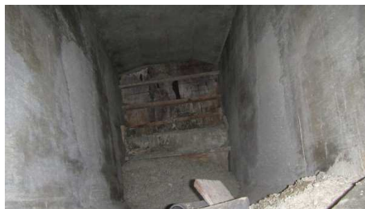
Obrázek P2. 8: Pohled do komory 4. nosníku 4/4
