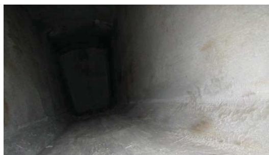
Obrázek P2. 14: Pohled do komory 5. nosníku 1/3
