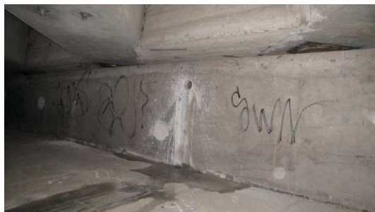
Obrázek P2. 43: Pohled na zkušební místo VO4 (opěra OP4)
