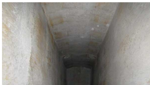
Obrázek P2. 16: Pohled do komory 5. nosníku 3/3
