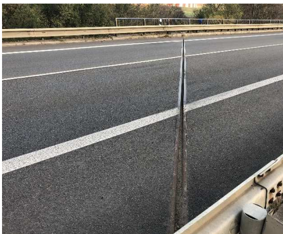
Obrázek 34: Povrchový mostní závěr nad OP4 [41]
