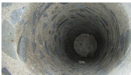
Obrázek P2. 45: Pohled do provedeného vývrtnu v pilíři (sonda VO4)
