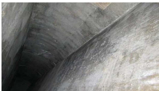
Obrázek P2. 5: Pohled do komory 4. nosníku 1/4
