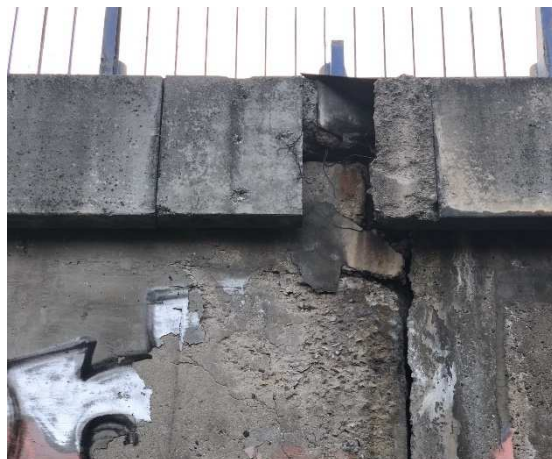
Obrázek 29: Detail ukončení vrchního plechu mostního závěru v místě říms z lícních prefabrikátů, závěrná zídka OP1, pravá strana [41]
