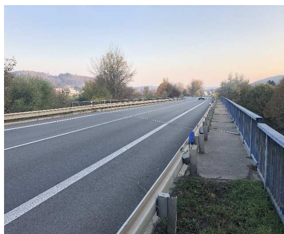
Obrázek 31: Pohled proti směru staničení ve směru na Brno [41]
