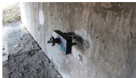
Obrázek P2. 50: Zkušební místo PO4, osazení trhacím přístrojem
