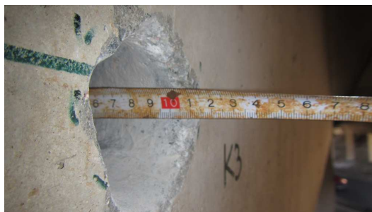
Obrázek P3. 10: Délka provedeného vrtu na sondě K-3
