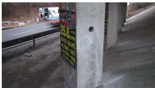
Obrázek P2. 31: Zkušební místo pro odběr jádrového vývrtu VP3
