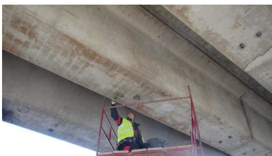
Obrázek P2. 13: Zapravení zkušebního otvoru pomocí sanační malty
