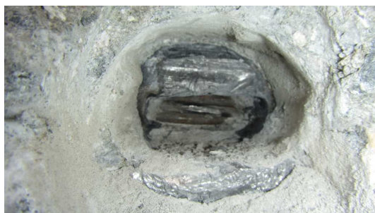
Obrázek P3. 3: Detail stavu chráničky – sonda K-1
