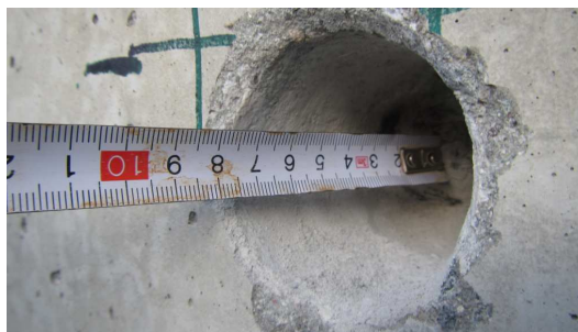
Obrázek P3. 26: Délka provedeného vrtu na sondě K-7
