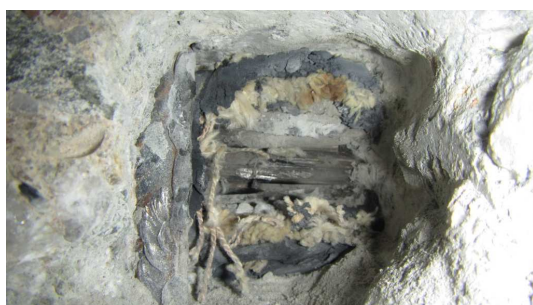
Obrázek P3. 23: Detail stavu chráničky – sonda K-6
