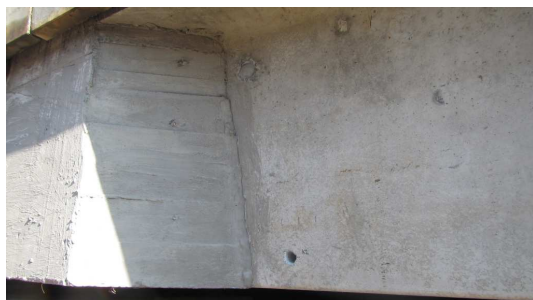
Obrázek P3. 5: Pohled na zkušební místo na stěně nosníku (sonda K-2)
