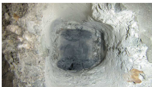
Obrázek P3. 19: Detail stavu chráničky – sonda K-5
