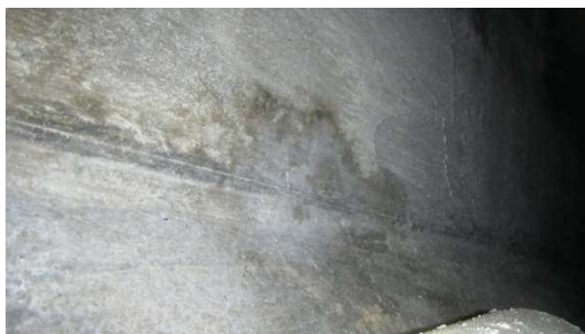
Obrázek P2. 7: Pohled do komory 4. nosníku 3/4
