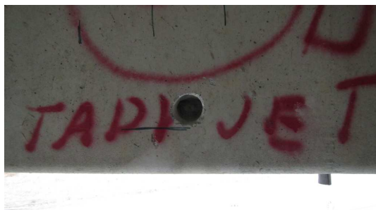
Obrázek P3. 29: Pohled na zkušební místo na stěně nosníku (sonda K-8)
