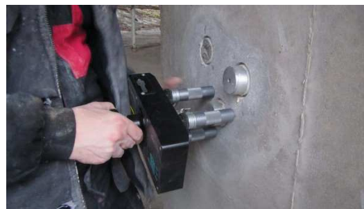
Obrázek P2. 36: Provádění odtrhové zkoušky pomocí automatického trhacího přístroje Proceq DYNA DY-16
