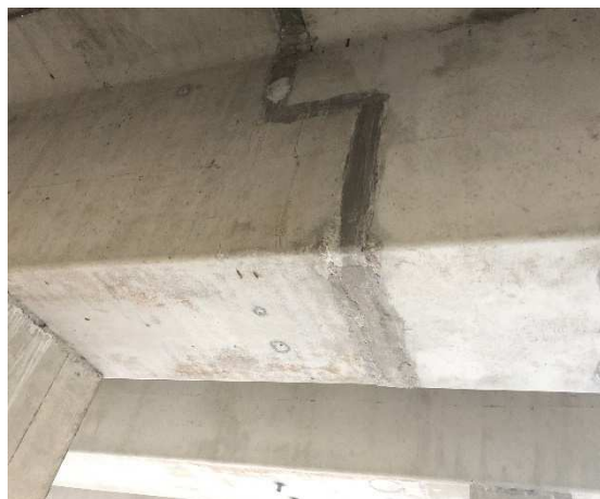
Obrázek 27: Detail podélného spojení jednotlivých nosníků ozubem s utěsněnou příčnou spárou [41]
