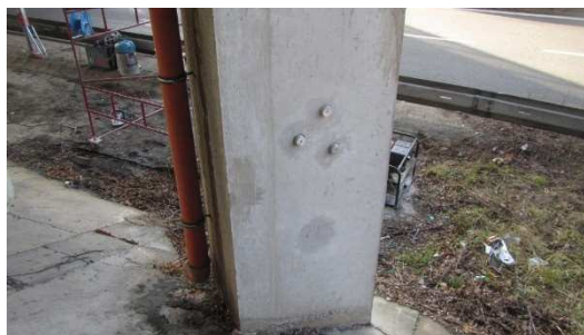
Obrázek P2. 37: Pohled na zkušební místo PP3 s nalepenými zkušebními terči
