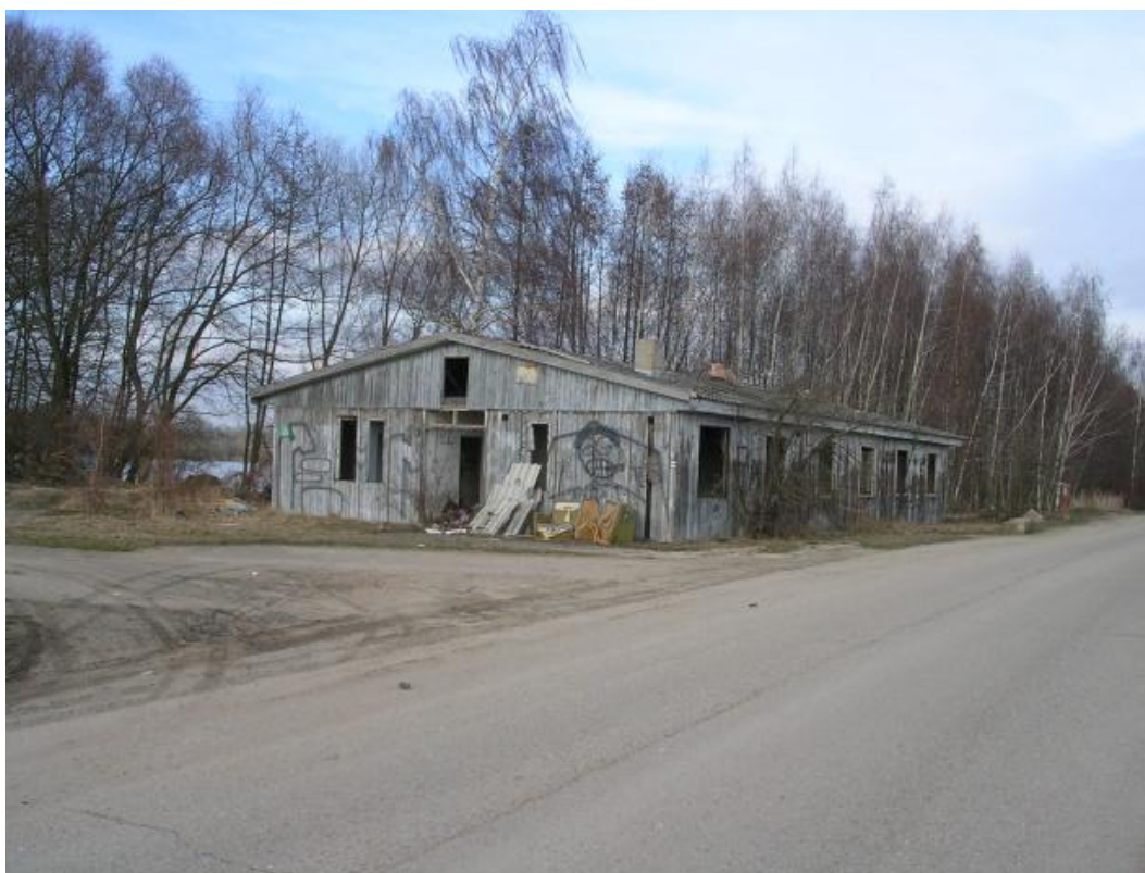
Příloha 12.: Opuštěná budova po ukončení těžby v dobývacím prostoru Poděbrady – Kluk (foto: J. Braun, 2010)
