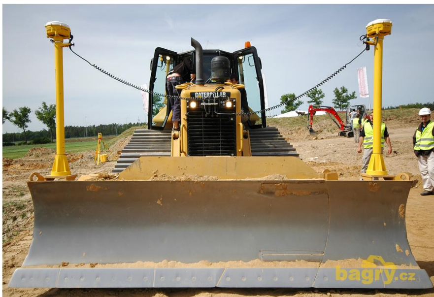
Obr. 14 Buldozer Caterpillar řízený dvěma přijímači Gps
