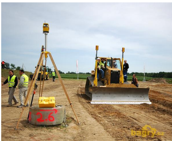
Obr. 11 Buldozer Caterpillar řízený laserem umístěným na stativu
