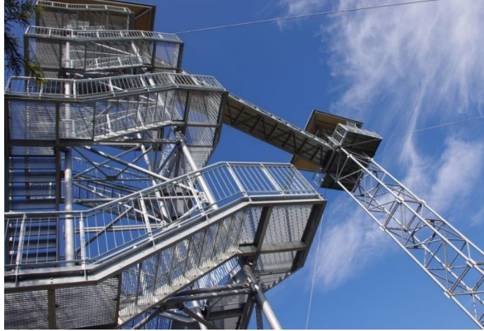
Obr. 15 Schodiště na věži A [2]
