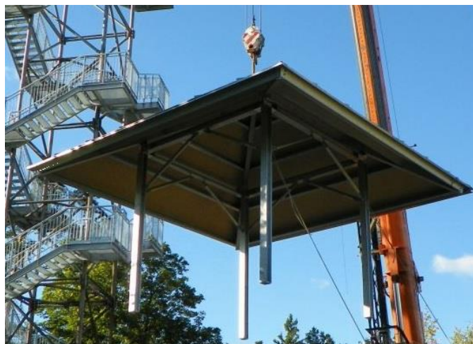
Obr.16 Střecha věže A [2]
