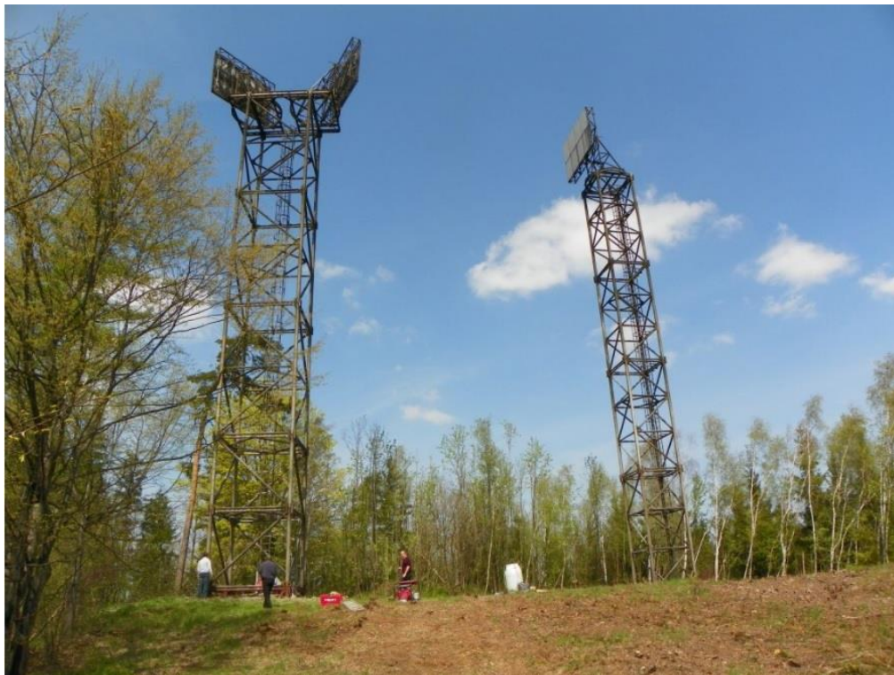
Obr. 1 Původní telekomunikační věže [2]
