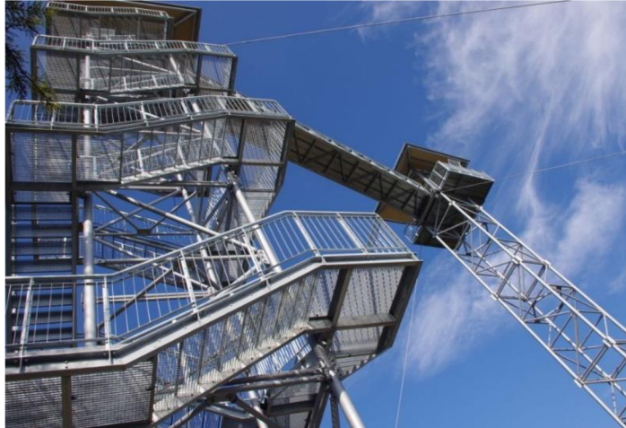
Obr. 15 Schodiště na věži A [2]
