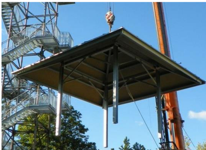
Obr.16 Střecha věže A [2]
