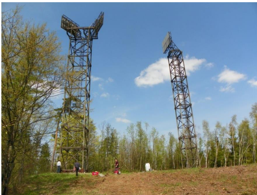
Obr. 1 Původní telekomunikační věže [2]
