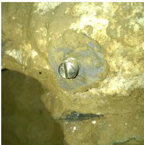
Obr. 5.1 Stabilizace nerezovým šroubem
