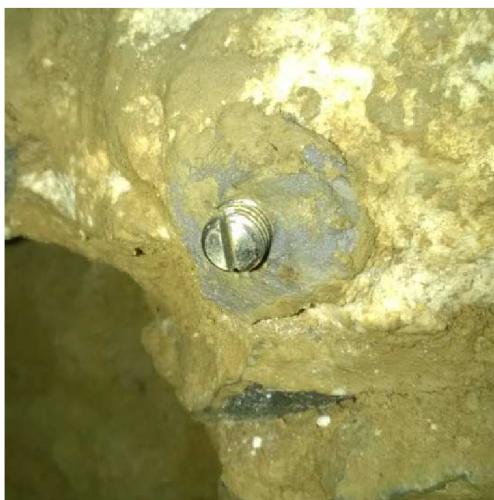
Obr. 5.1 Stabilizace nerezovým šroubem
