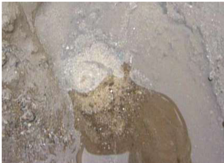
Obr. 3.19 Vyplavování zeminy (Foto - Žatecký)
