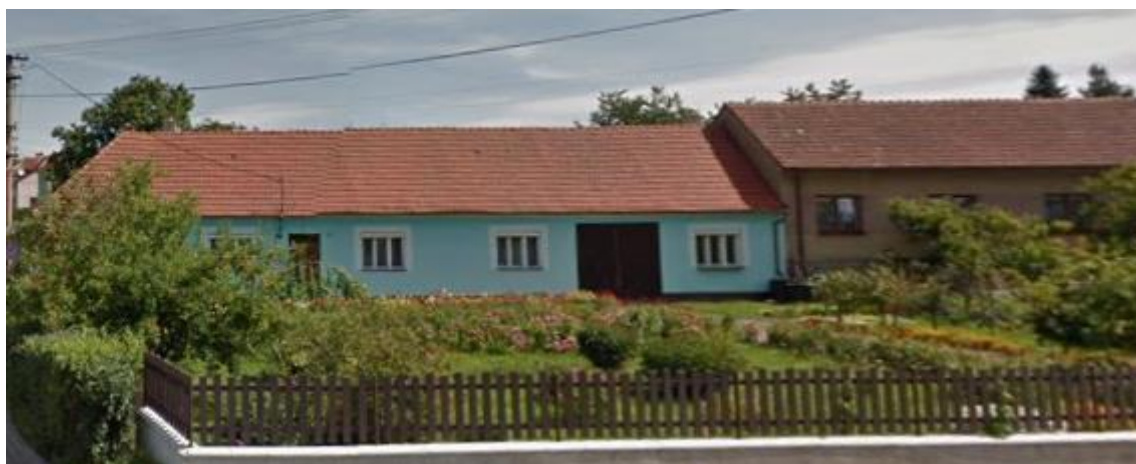
Obr. 41 – Snímek čelní strany budovy na parcele st. 72/1 [13] 11. 5. 2014
