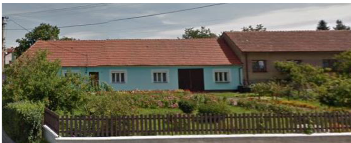
Obr. 41 – Snímek čelní strany budovy na parcele st. 72/1 [13] 11. 5. 2014
